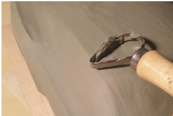
Imagen 78 Vaciado de superficies grandes
