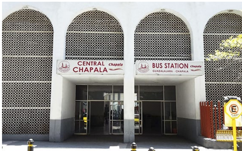
Ilustración 26. Estación de Autobuses de Chapala (Autotransportes Guadalajara, 2022).
