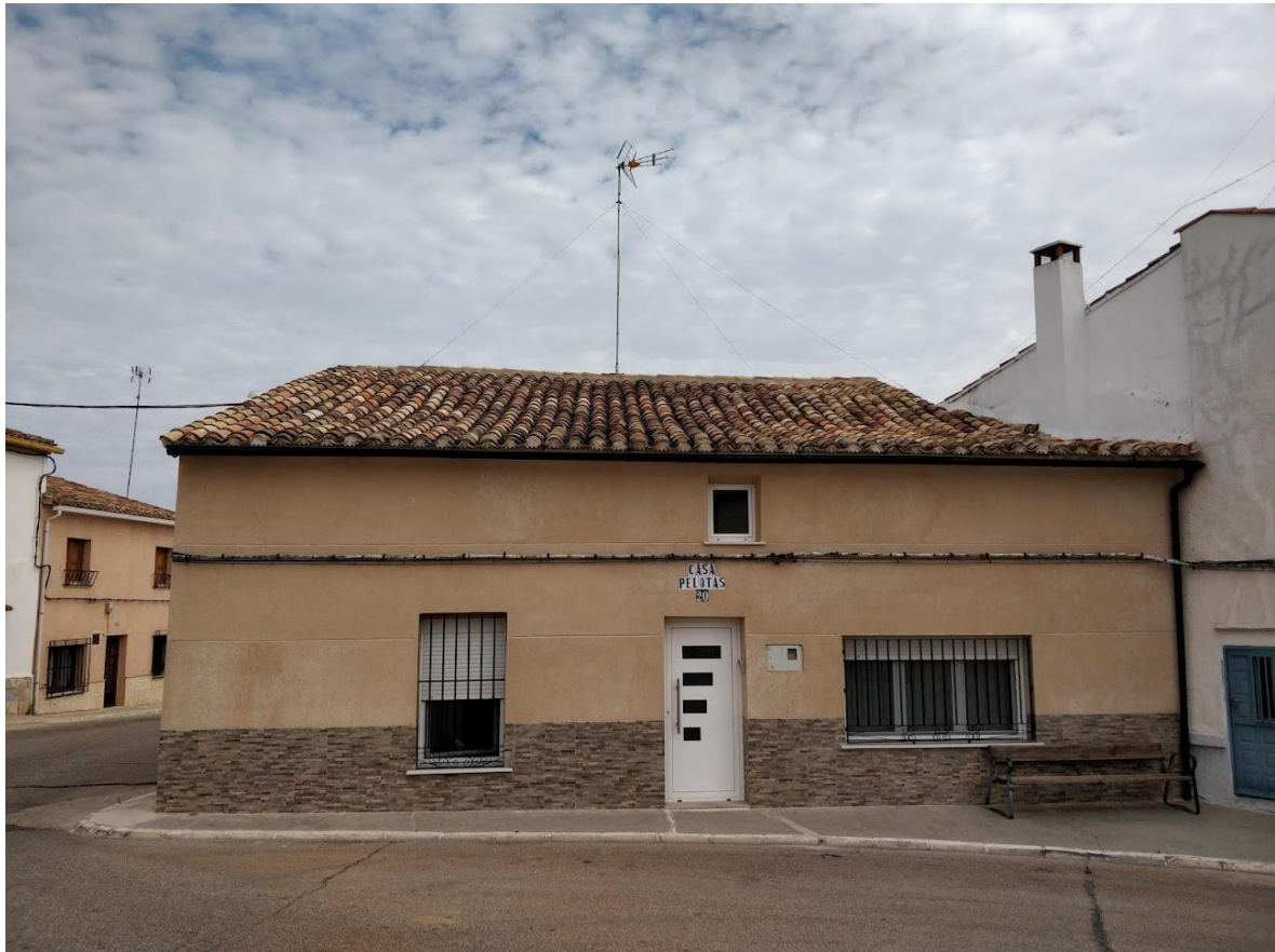
Imagen 3. Estado actual de la vivienda. (Fuente: Propia)
