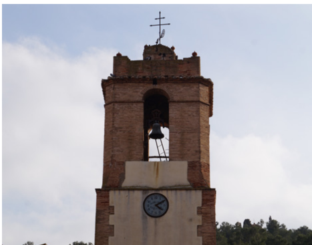
Figura 61. Campanario de la Iglesia de Rasquera. (Elaboración propia, 2021).
