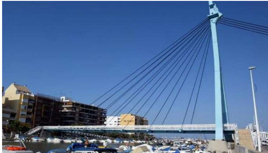
Figura 13. Pasarela de tipo atirantada. Fuente: Levante emv. https://www.levante-emv.com/valencia/2008/05/21/perello-moviliza-cierre-posible-derribo-13434475.html
