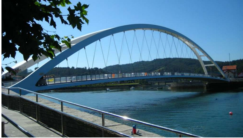
Figura 8. Puente Arco. Fuente: puentemania http://www.puentemania.com/607
