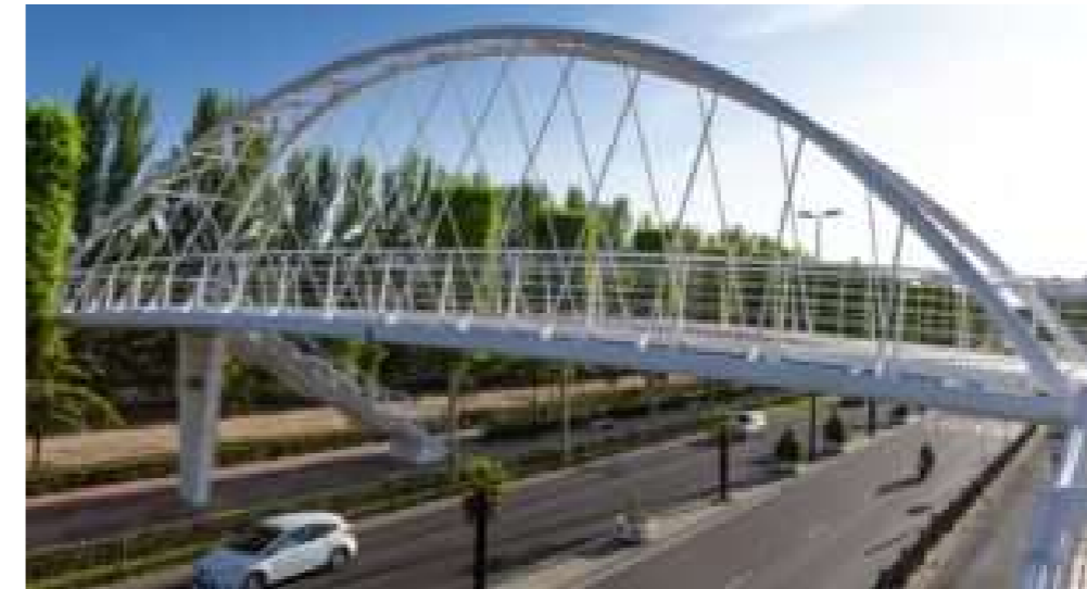
Figura 3. Pasarela peatonal tipo arco que produce un gran impacto. Fuente AIA. https://estudioaia.com/proyectos/pasarela-arco- -talavera-la-reina-2/
