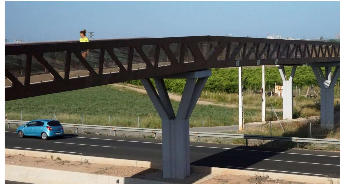
Figura 11. Pasarela de tipología Howe. Fuente: PREFFOR. https://preffor.com/proiect/pasarela-formex-uhpc-howe/
