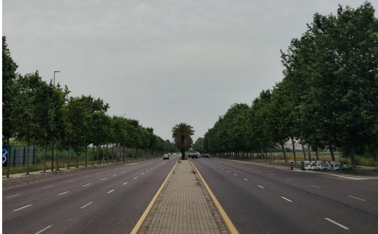
Fotografía Nº1. Boulevard Perifèric Nord desde la mediana de la avenida.
