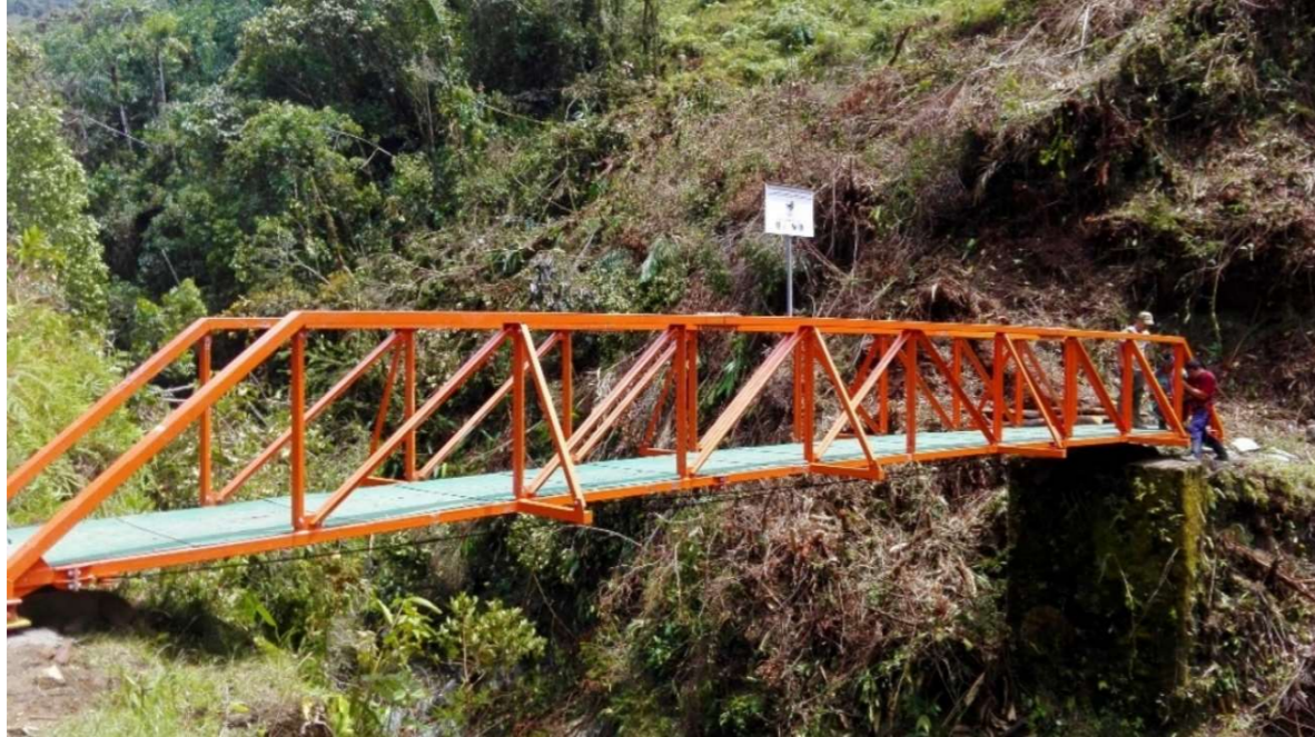
Figura 9. Pasarela de viga tipo Howe. Fuente: Puentes de la Esperanza. http://www.puentesdelaesperanza.org/nuestros-puentes
