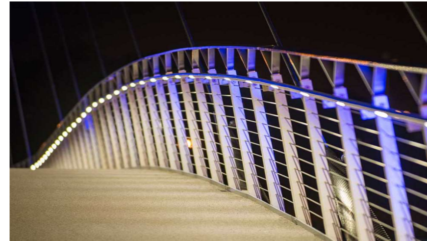
Figura 5. inspiración del alumbrado interior. Fuente: interempresas.net https://www.interempresas.net/Iluminacion/Articulos/150893-Solucion-LED-para-la-barandilla-del-nuevo-puente-peatonal-sobre-el-rio-Tamesis.html
