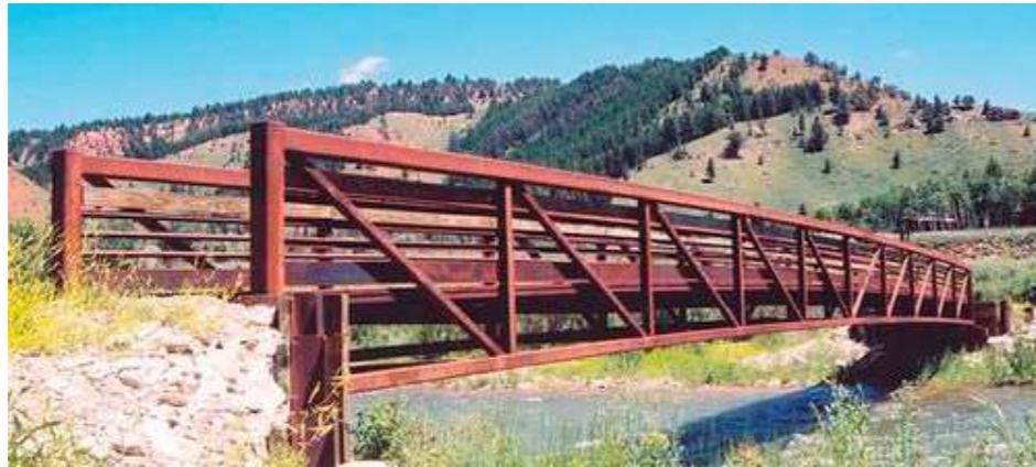
Figura 9. Pasarela de tipología Pratt. Fuente: https://www.archiexpo.es/prod/short-span-steel/product-132999-1550566.html
