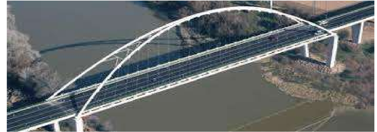
Figura 2. Puente tipo arco. Fuente: RiuNet UPV. https://riunet.upv.es/bitstream/handle/10251/72741/01_Memoria.pdf?sequence=1
