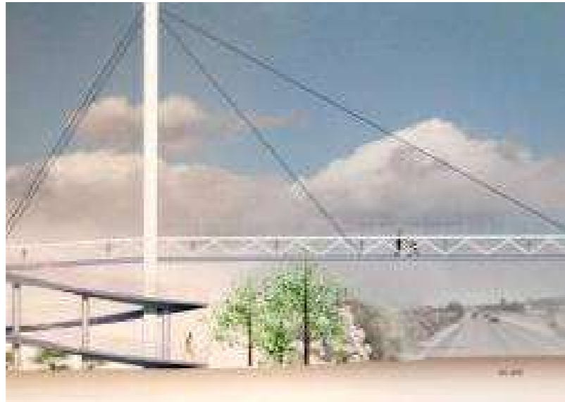
Figura 13. Pasarela atirantada con rampas. Fuente: Las provincias . https://www.lasprovincias.es/20100804/comunitatvalenciana/hortamorvedre/consell-prepara-proyecto-pasarela-201008041632.html
