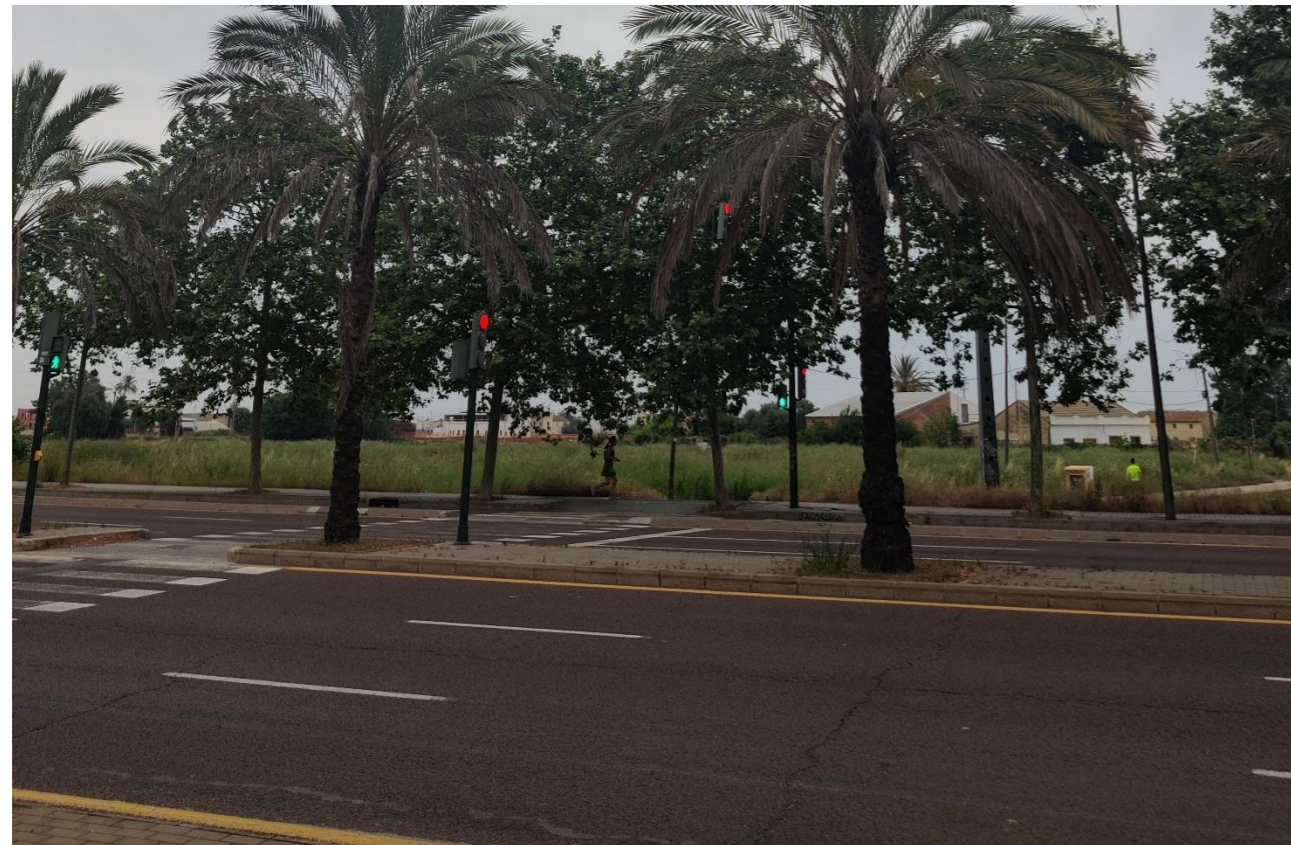
Fotografía Nº14. Estado de la calzada de Boulevard Perifèric Nord por el lado urbano.
