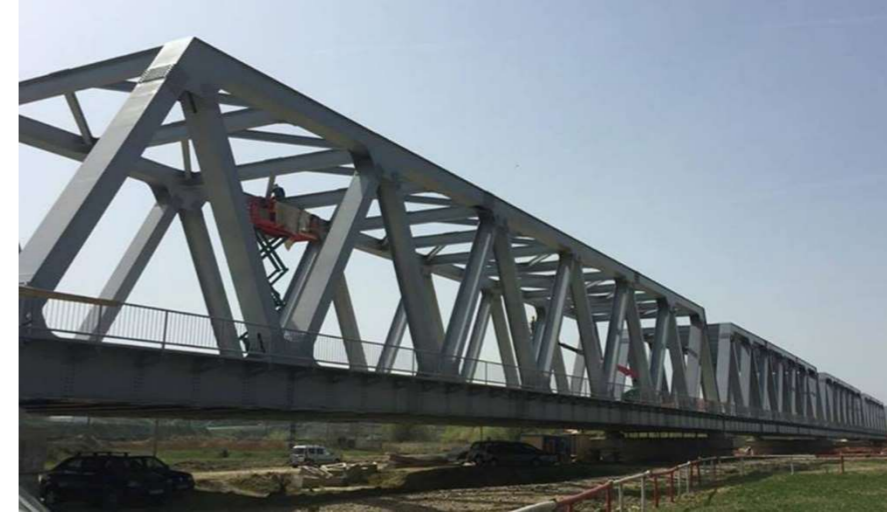
Figura 10. Puente de tipología Warren. Fuente: Grupo Azvi. https://www.azvi.es/el-ministro-de-transporte-de-rumania-visita-las-obras-de-azvi-en-el-ferrocarril-simeria-brasov/
