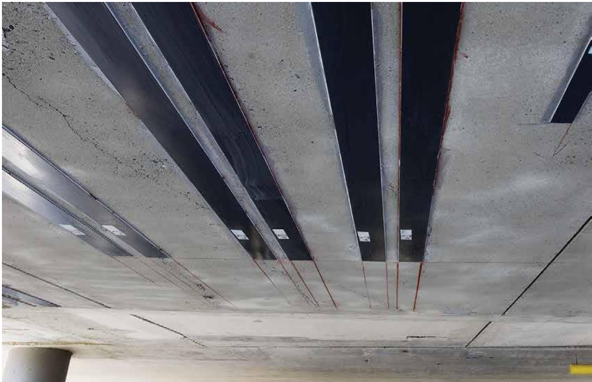
Figura 62. Ejemplo de refuerzo con Carboplate en un puente de hormigón armado [38].
