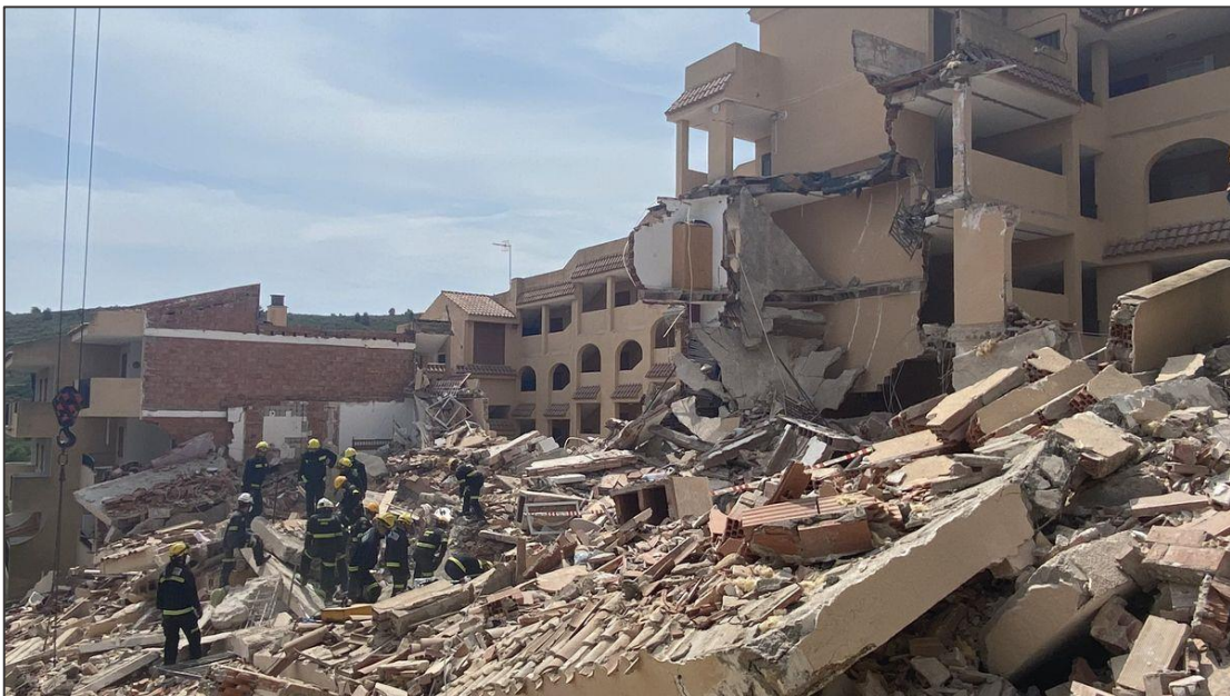
Figura 5. Colapso del edificio de viviendas en Peñíscola, Castellón (2021) [7].
