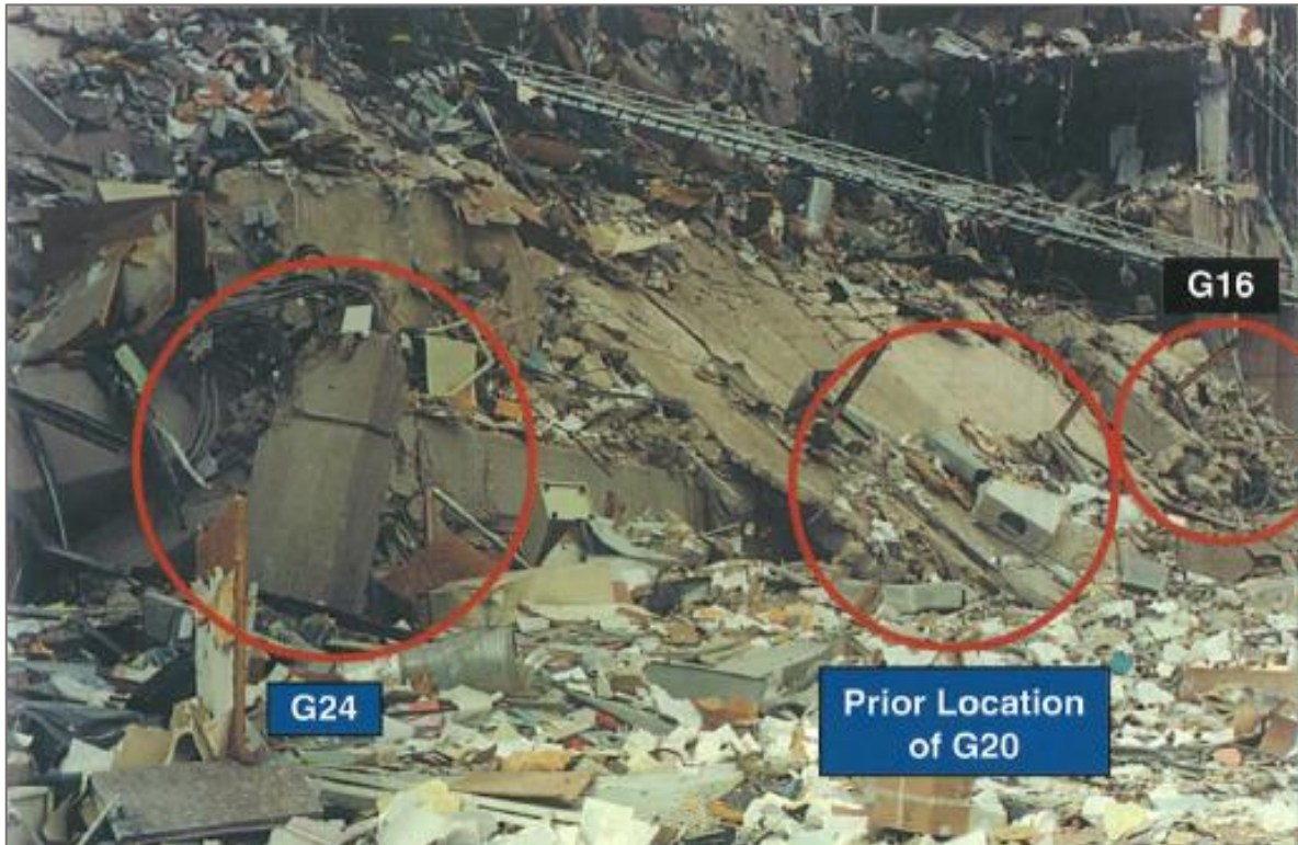
Figura 27. Fotografía que muestra el resultado de las columnas en la rejilla G tras la explosión.[22]
