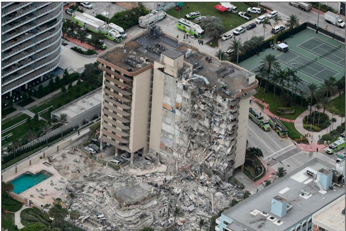
Figura 6. Estado del edificio que colapsó en Miami antes de su demolición [8].
