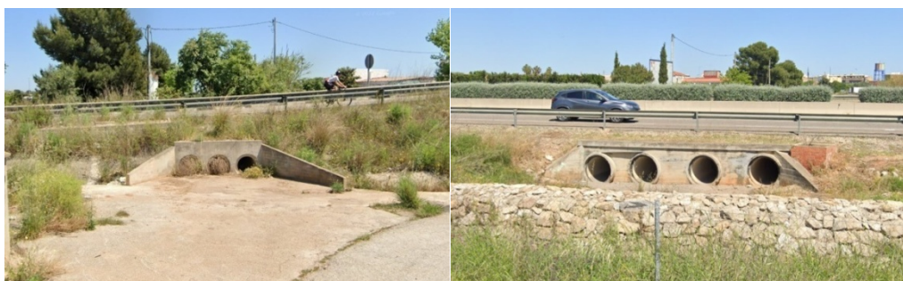
Figura 13. A la izquierda, obra de drenaje transversal de la ubicación 1. A la derecha, obra de drenaje transversal de la ubicación 2. (Fuente: Google Maps)
