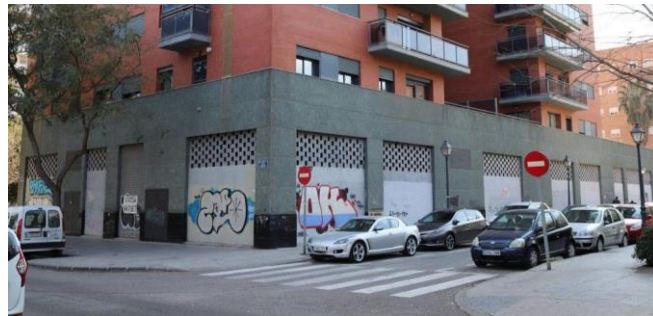
Imagen 12. Exterior del local 5
