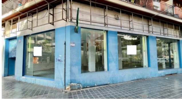
Imagen 7. Exterior del local 2
