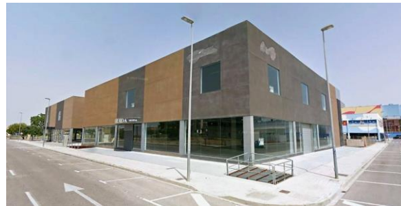
Imagen 4. Exterior del local 1
