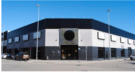
Imagen 9. Exterior del local 3
