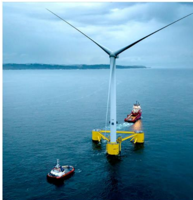
Figura nº 36.- Estructura flotante de tipo semi-sumergible de tres columnas.
