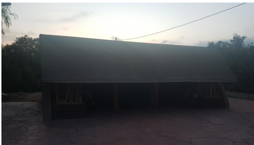
Figura 93 Apertura parcial del techo exterior
