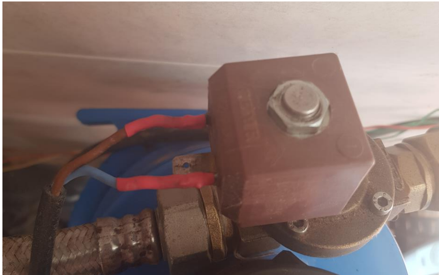
Figura 63 Conexiones electroválvula
