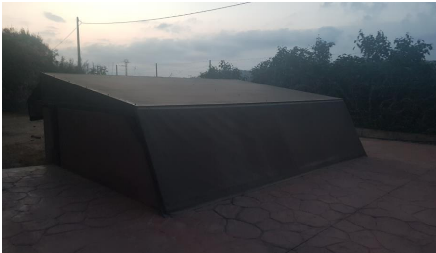
Figura 92 Cierre completo del techo exterior
