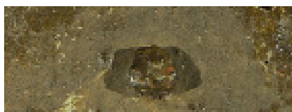
Figura 37: Cabota del clau oxidat que sobreix a la superfície de la cabellera.
