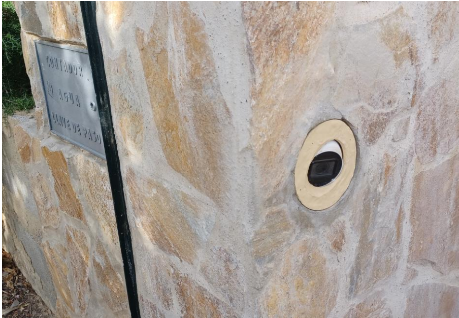
Figura 53 Cámara captura matrículas con sensor de ruido integrado en marco
