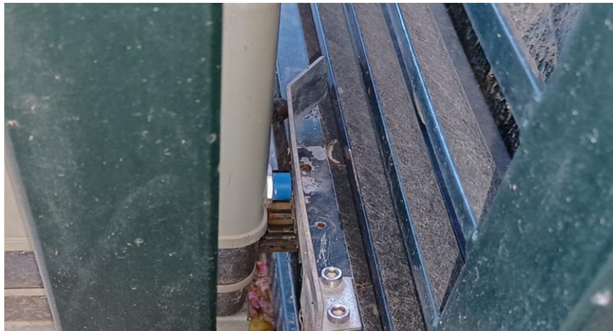
Figura 51 Sensor inductivo detectando puerta cerrada
