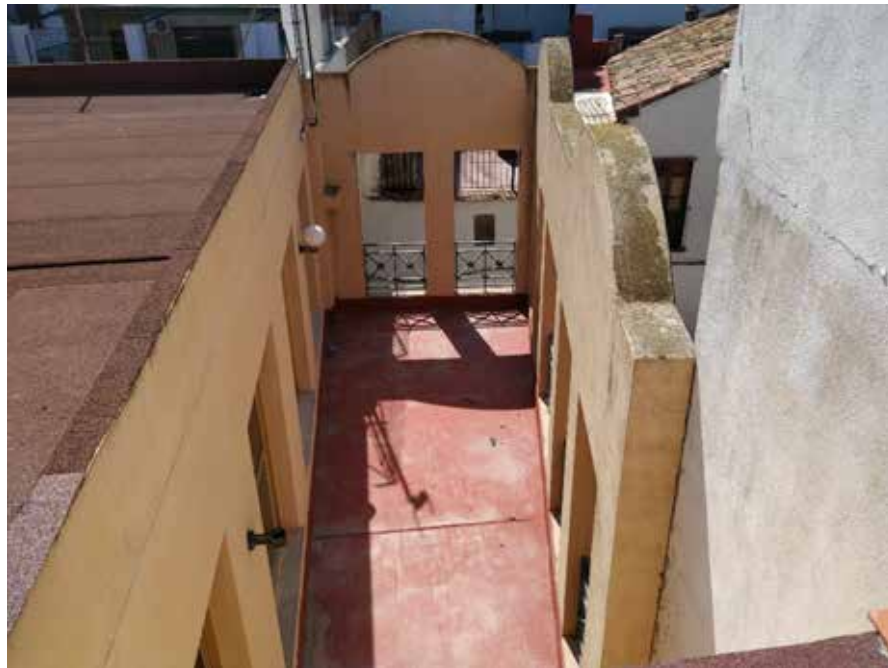
Imagen 26. Terraza de la fachada a la calle Poeta Zorrilla
