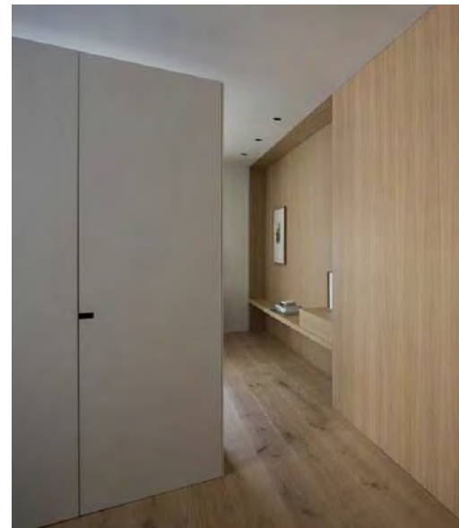
2. Panelado de madera lacado en blanco para espacios de almacenaje
