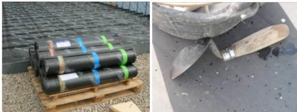
Materiales, herramientas y equipos empleados en la impermeabilización
