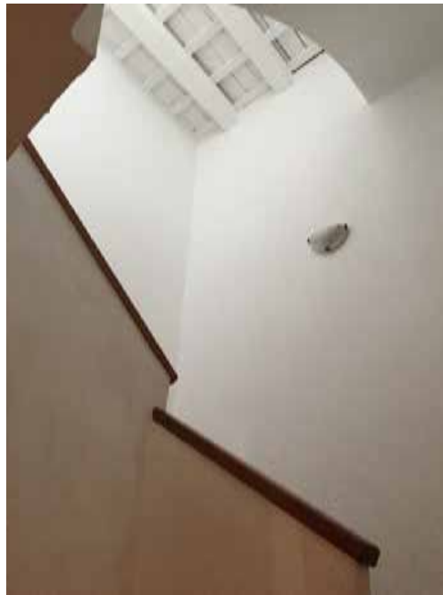
Imagen 1. Interior escalera de la torre Miramar.
