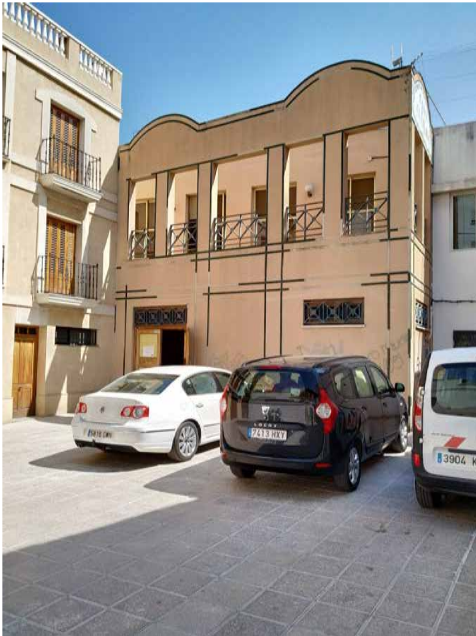
Imagen 27. Fachada a la calle Poeta Zorrilla
