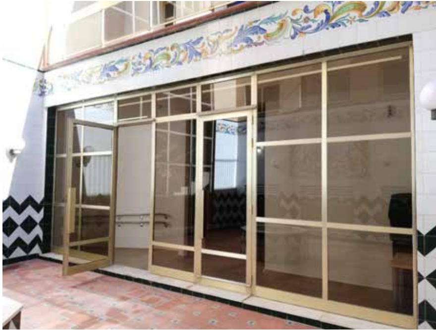
Imagen 10. Carpintería recayente al patio.
