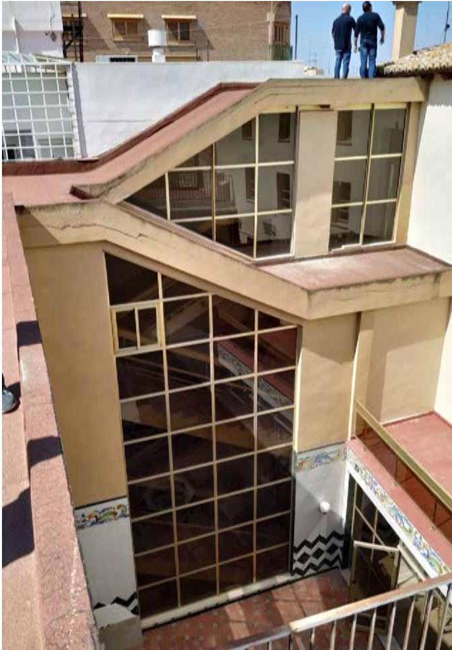
Imagen 13. Carpintería recayente al patio.
