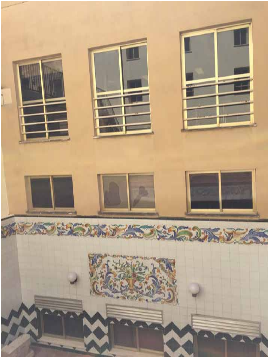
Imagen 12. Carpintería recayente al patio.
