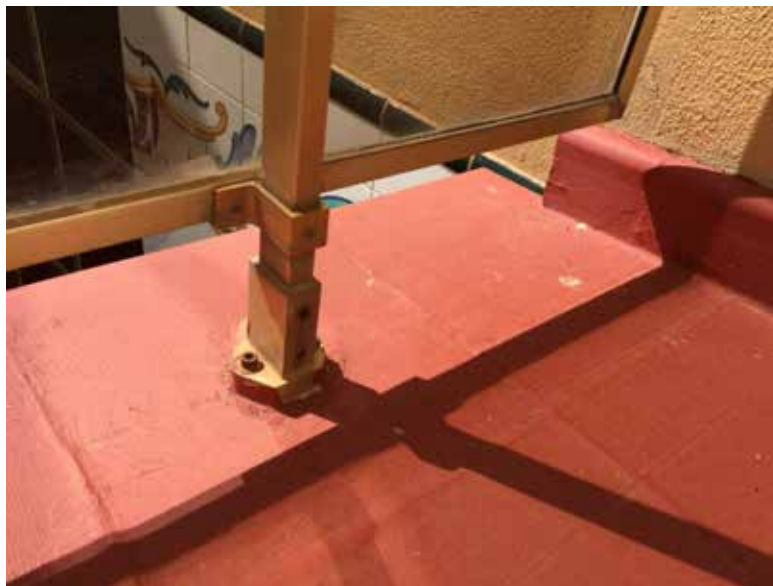
Imagen 18. Anclaje de la barandilla de la terraza.
