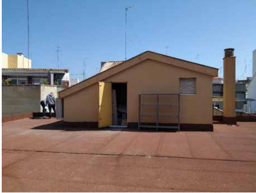
Imagen 25. Casetón de cubierta.
