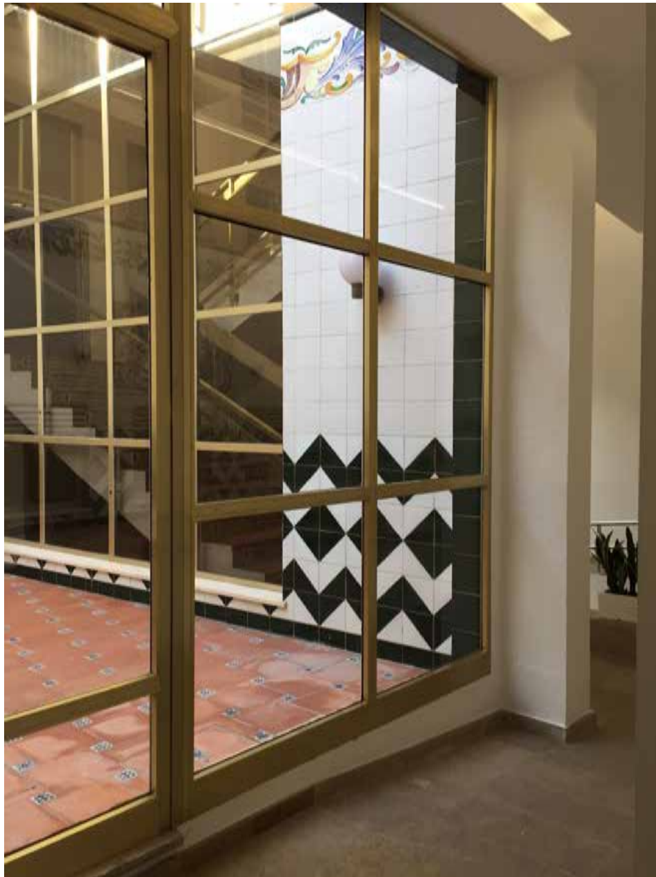
Imagen 4. Carpintería recayente al patio.
