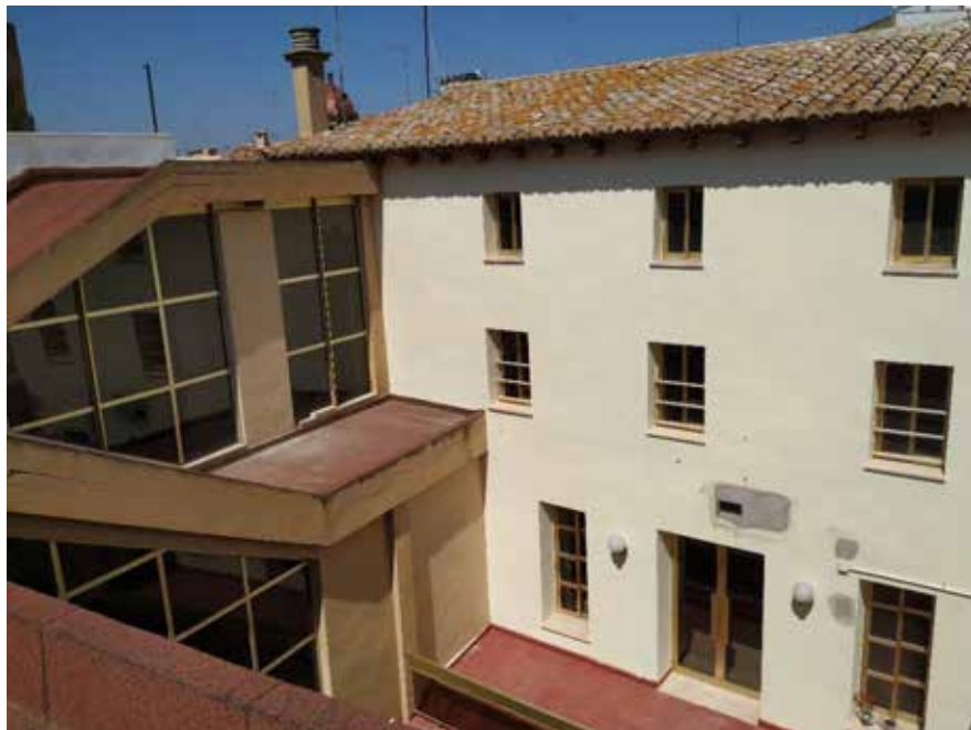
Imagen 11. Carpintería recayente al patio.
