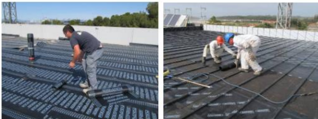
Trabajos de impermeabilización horizontal
