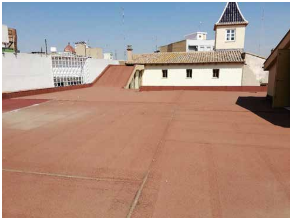
Imagen 24. Acabado actual de la cubierta
