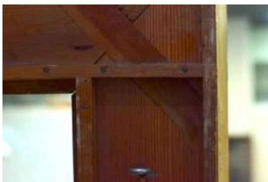
Fig. 37. Detalle del ensamblaje con barra a inglete.
