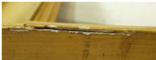
Fig. 64. Desconsolidación de la escayola.
