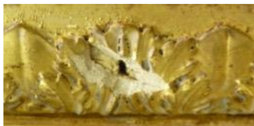
Fig. 65. Laguna en la moldura.
