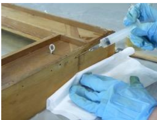
Fig. 88. Tratamiento contra ataques xilófagos por inyección.
