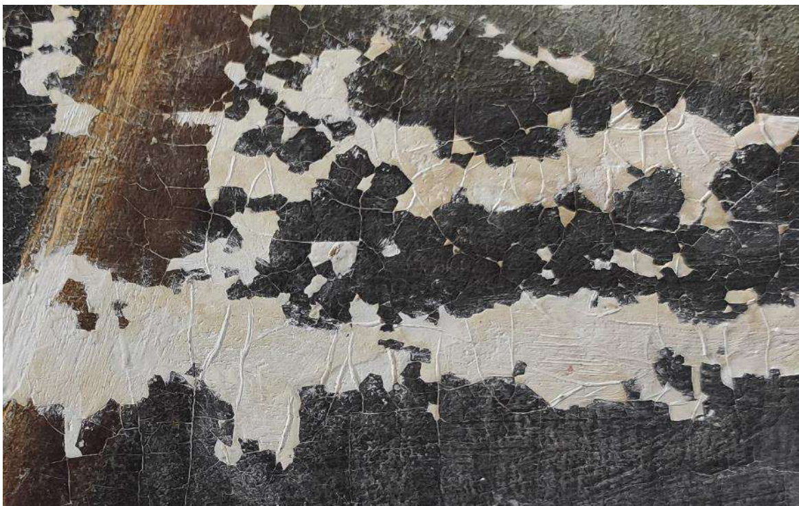
Figura 102. Detalle de estuco texturizado mediante técnica incisiva.
