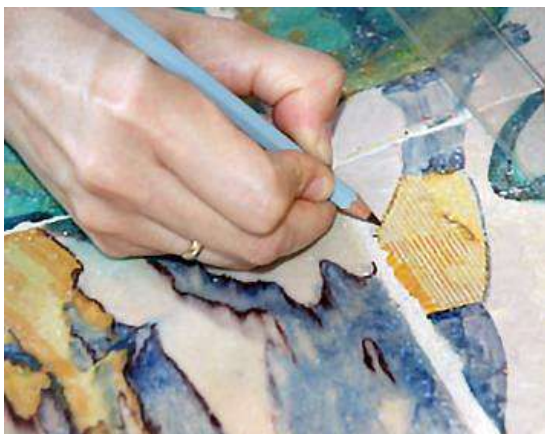
Figura 160. Detalle del proceso de reintegración cromática mediante reglatino con lápices acuarelables realizado en el pavimento cerámico Los cuatro elementos , siglo XVII, Galería Dorada del Palau Ducal de Gandía.
