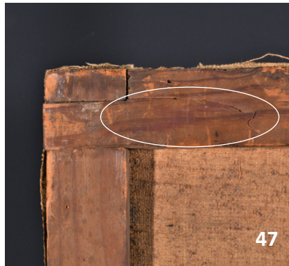
Fig.47.- Zona agrietada por la unión del bastidor que causa gran inestabilidad
