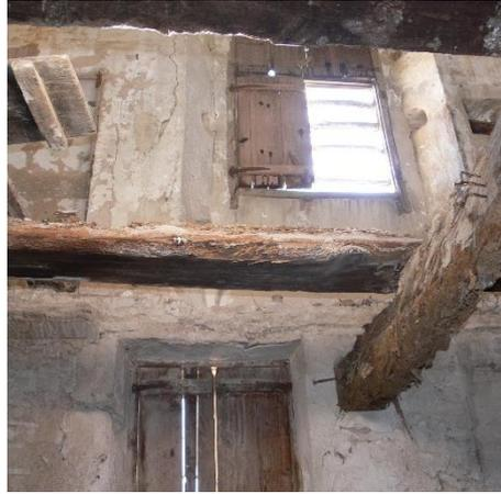
Figura 15. Vista de la estructura del desván con la desaparición del forjado
