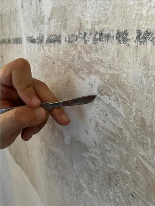
**Figuras 191.** Extracción del encalado mediante escalpelo
