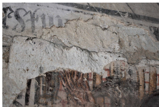
Figura 68. Detalle de las capas de guarnecido.
