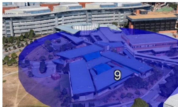
Ilustración 31: Ubicación final del pararrayos 2 sobre el edificio 3.
