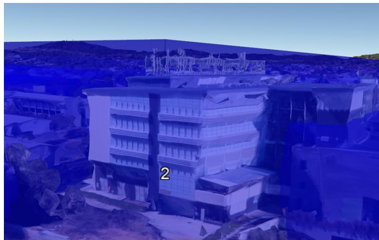
Ilustración 29: Ubicación final del pararrayos 2 sobre el edificio 3.
