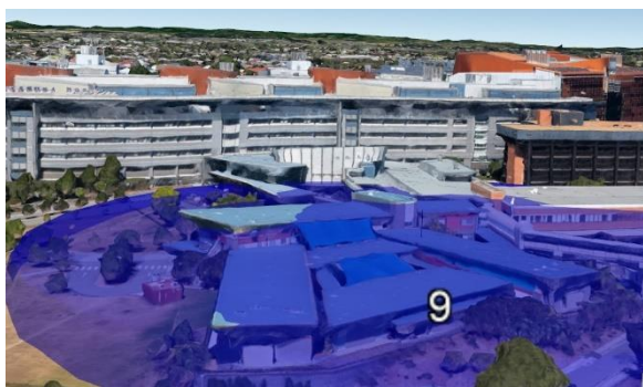
Ilustración 30: Ubicación inicial del pararrayos 9 sobre el edificio 6.
