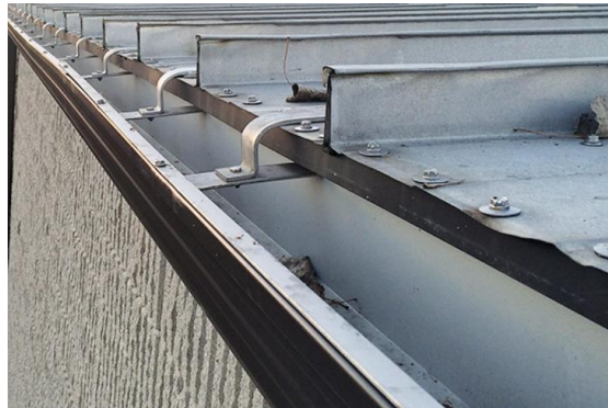
Figura 29 -Evacuación de aguas
