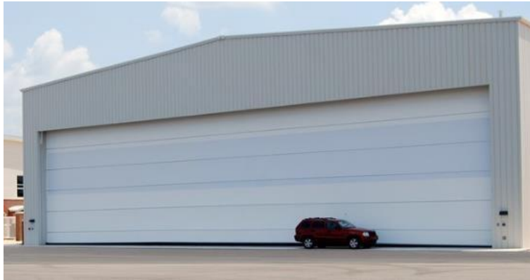
Figura 30 - Cerramiento vertical tipo lona
