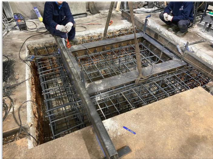
Figura 24. Imagen de la realización de la nueva cimentación de la prensa
