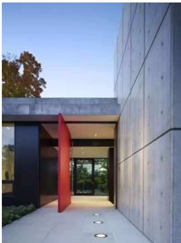
Imagen 67: Fachada de hormigón. Fuente: Decoraideas.com
