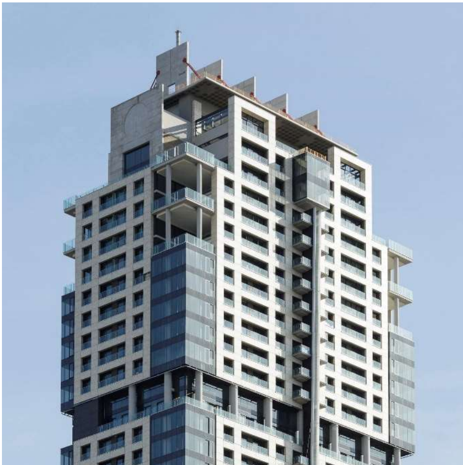
Imagen 30: Fachada ventilada Dekton. Fuente: Cosentino S.A.
