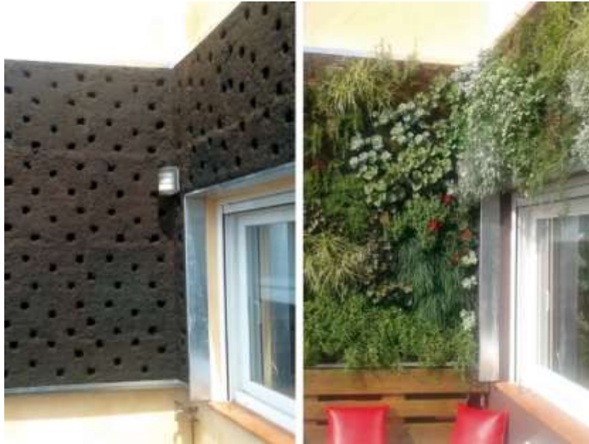
Imagen 57: Fachada vegetal de celdas drenantes. Fuente: Louvelia.com
