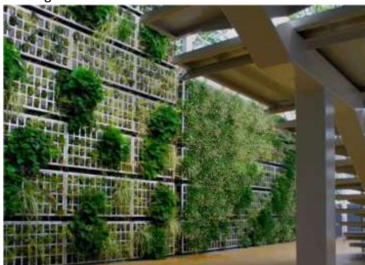
Imagen 52: Fachada vegetal de celdas de polietileno. Fuente: Inarquía.es
