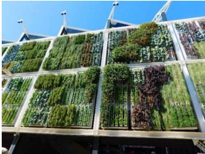
Imagen 56: Fachada vegetal de caja metálica. Fuente: Certicalia.com
