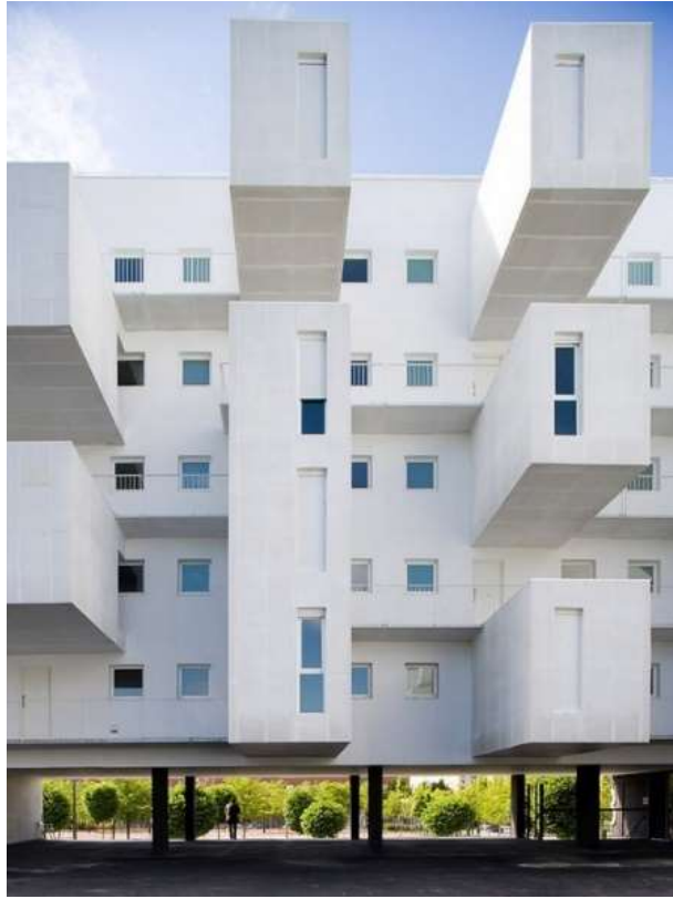
Imagen 72: Fachada con volumen. Fuente: Archdaily.com
