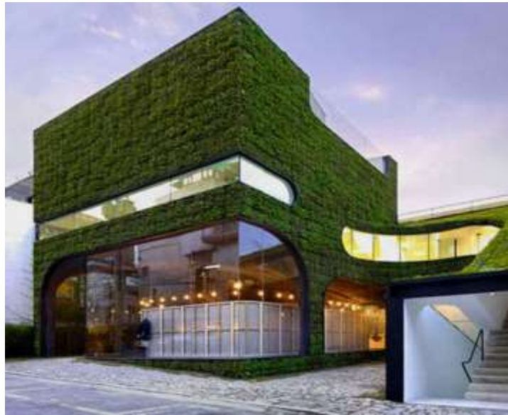
Imagen 47: Fachada eficiente energéticamente. Fuente: Cértico.es
