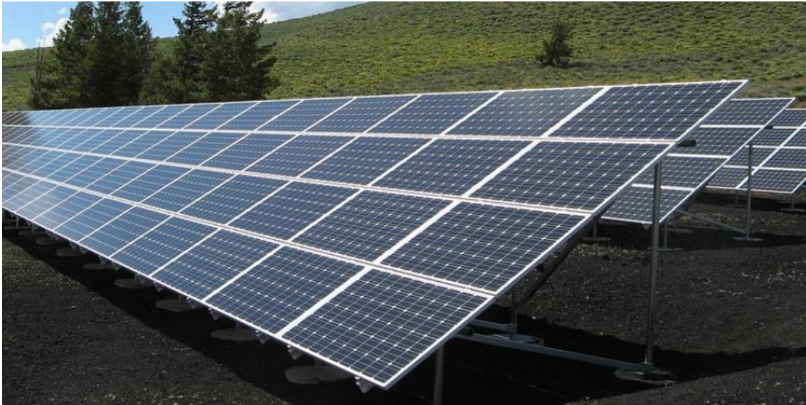
Figura 2.6: Imagen del montaje de paneles solares sobre estructura metálica, Ambientum.
