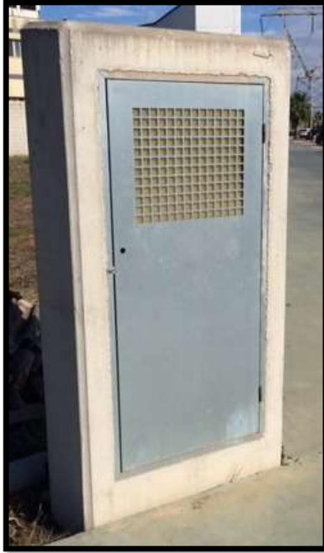
**Figura 7. Detalle de hornacina para protecciones eléctricas e inversor.**
