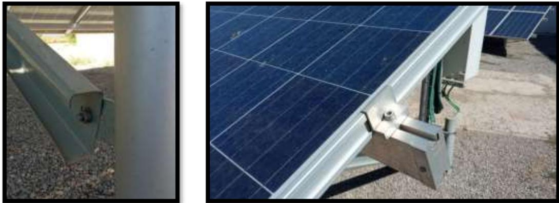
**Figura 9. Diagonal tipo CF (izq.) y correas perfiles 41/41 (der.).**
