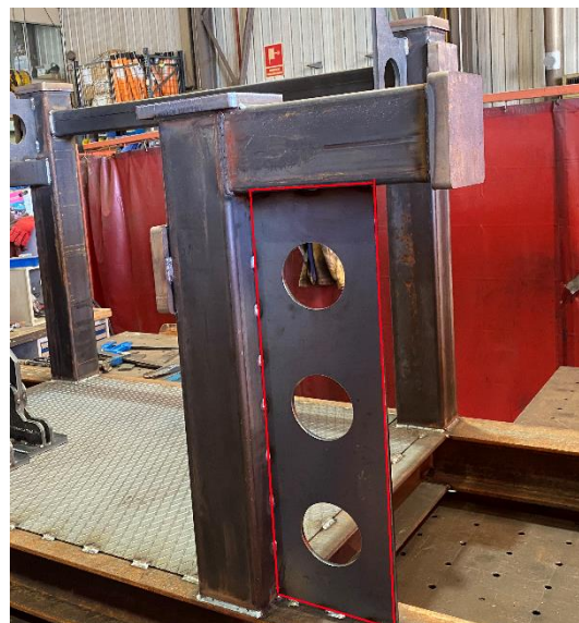
Figura 59. Chapa de refuerzo soldada.
