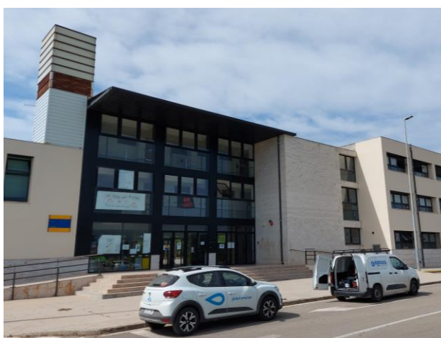
Figura 27. Edificio "I.E.S. Càrcer".
