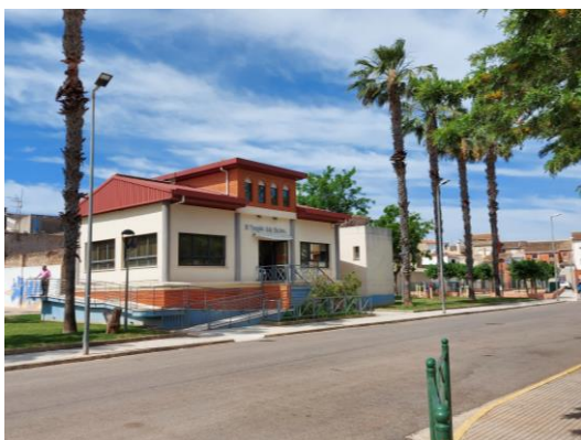
Figura 25. Edificio "El templet dels majors".
