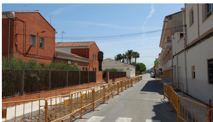
Figura 31. Estado de las obras de la calle Casto Monblanch.
