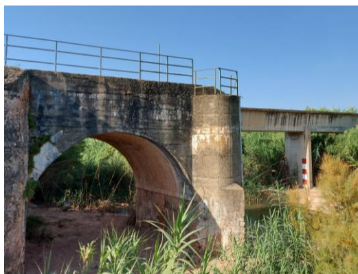
Figura 11. Estado actual de L'Arcà.
