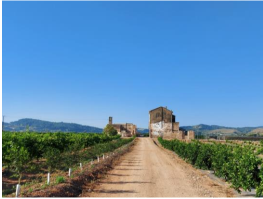
Figura 19. Camino de acceso a la Casa Abad. Fuente: Propia.
