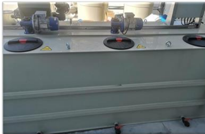
Figura 14. Cámara de preparación, de maduración y de almacenaje del polielectrolito sólido
