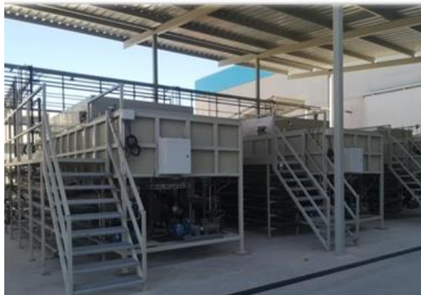
Figura 8. Sistema compuesto por los 3 DAFs
