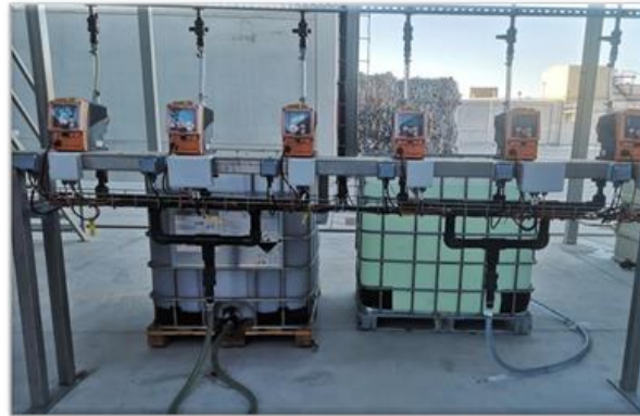
Figura 11. Bombas dosificadoras de sosa cáustica y coagulante
