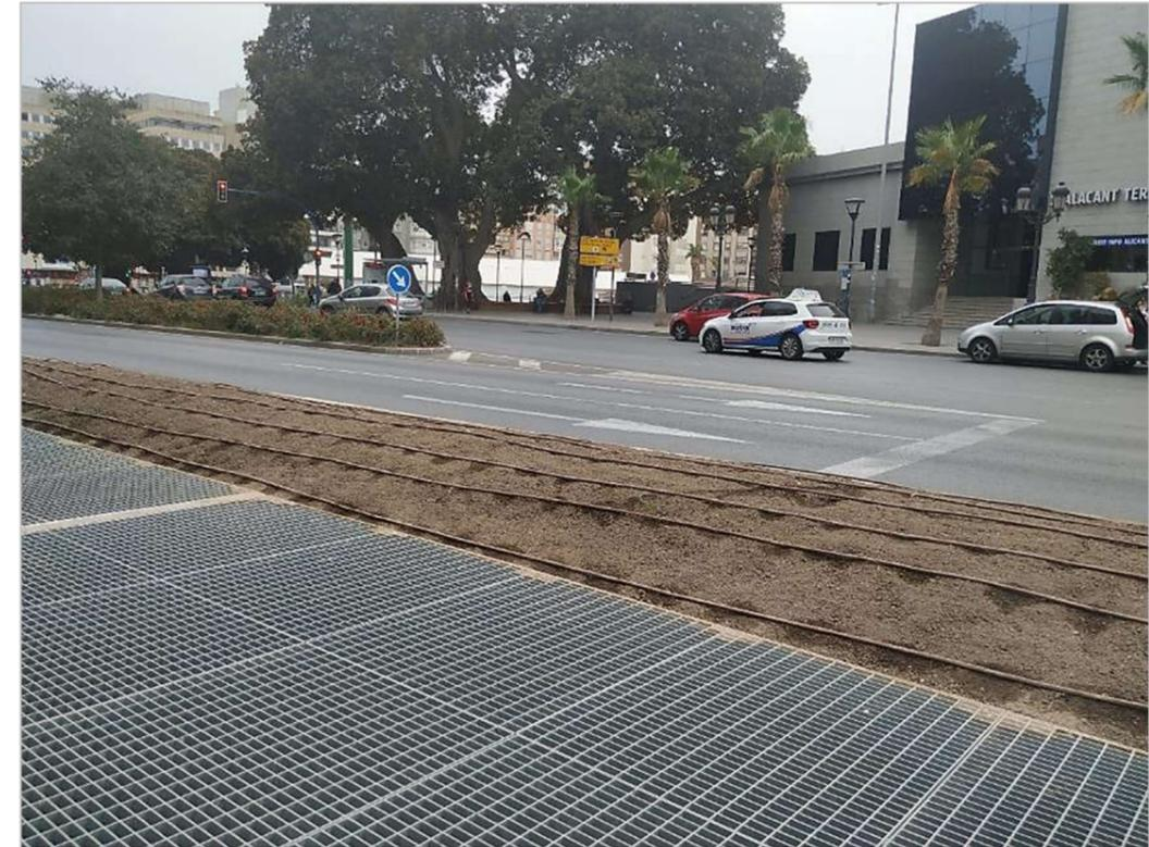
Fotografía 7. Estación de ADIF. Cruce de Av. Estación Cruce con Av. Salamanca-Rejillas ventilación final de culatón de maniobras. (Fuente: FGV)
