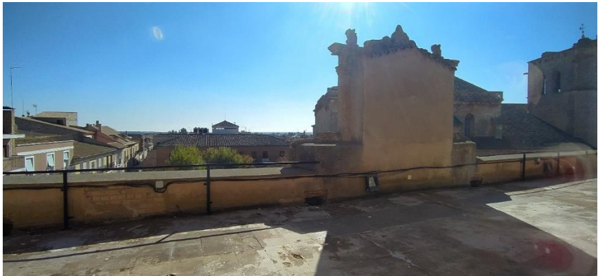
Imagen 7.1.14 Cubierta Plana. Vista 1
