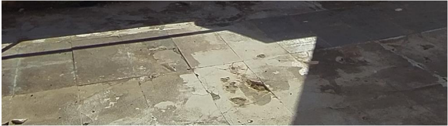
Imagen 7.1.22 Pavimento en la cubierta plana
