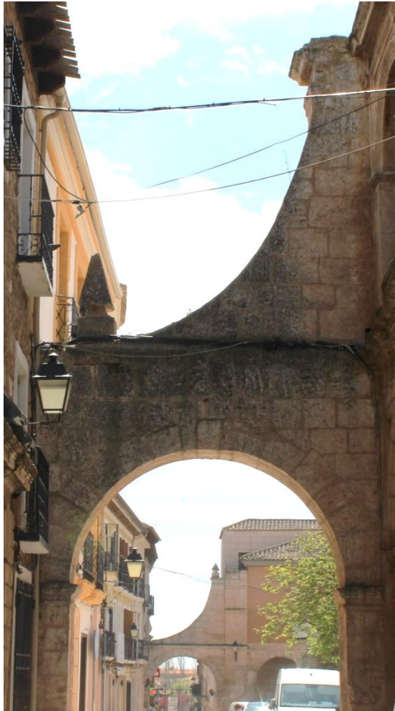
Imagen 9.1.17 Arco lateral. Vista 2
