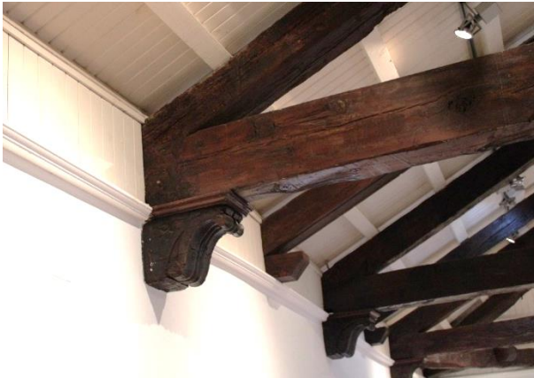
Imagen 7.1.12 Durmiente de madera y ménsula trabajada
