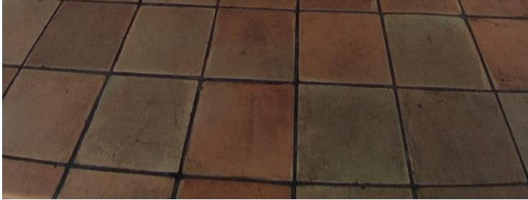
Imagen 7.1.20 Pavimento de baldosas cerámicas
