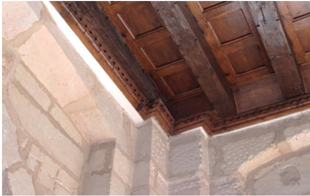
Imagen 7.1.4 Esquina de la estancia principal de la primera planta.
