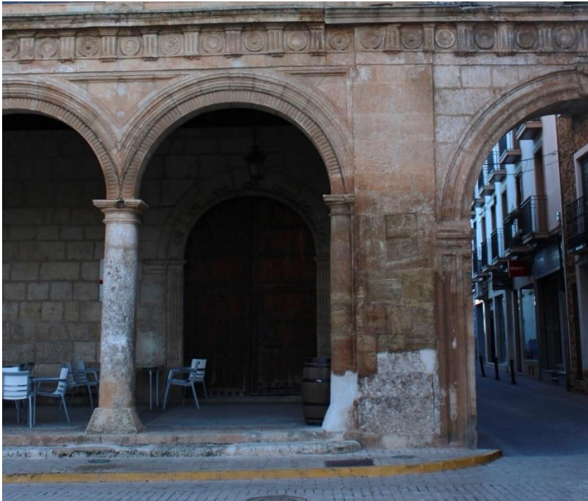
Imagen 5.3.3 Elementos de la fachada principal que han sido reconstruidos
