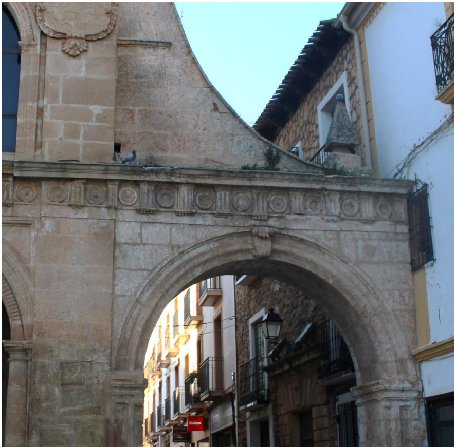
Imagen 9.1.16 Arco lateral. Vista 1
