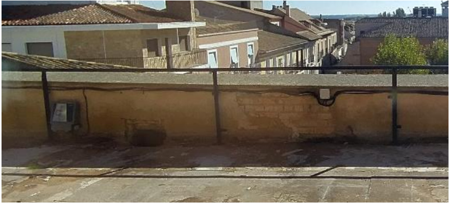
Imagen 9.1.24 Cubierta Plana. Vista 4
