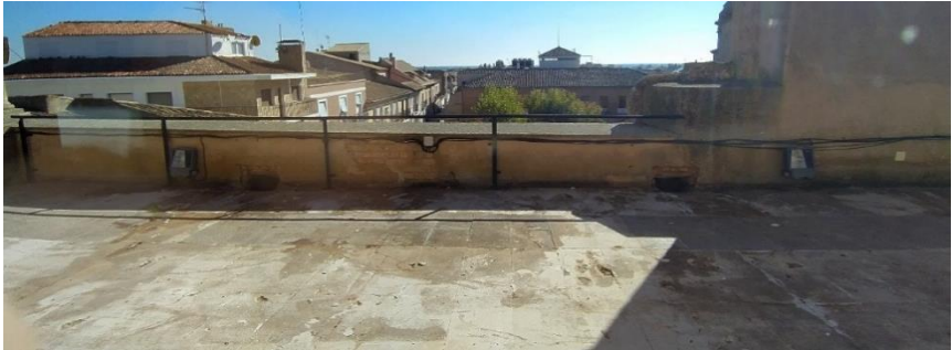
Imagen 9.1.23 Cubierta Plana. Vista 3
