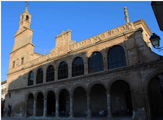
Imagen 2.2. Fachada Principal del antiguo Ayuntamiento de San Clemente. Fachada sureste.
