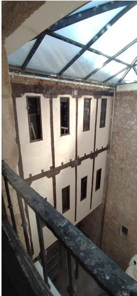
Imagen 9.1.4 Patio interior. Vista 2
