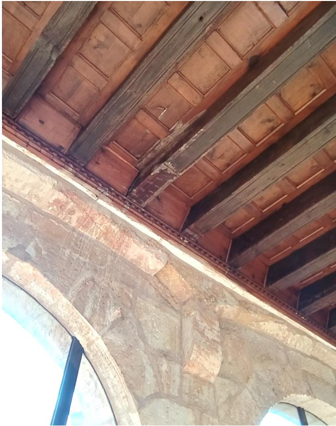
Imagen 9.1.5 Forjado de la primera planta. Vista 1
