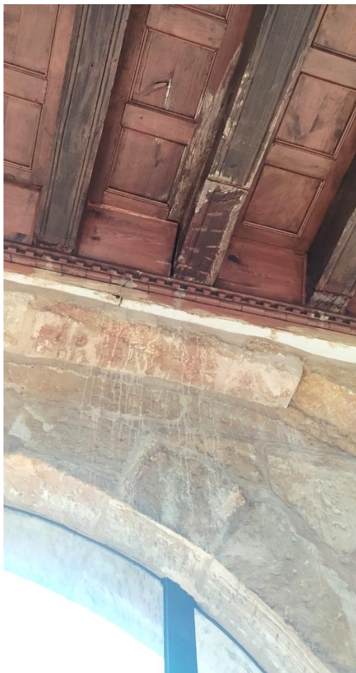
Imagen 9.1.6 Forjado de la primera planta. Vista 2
