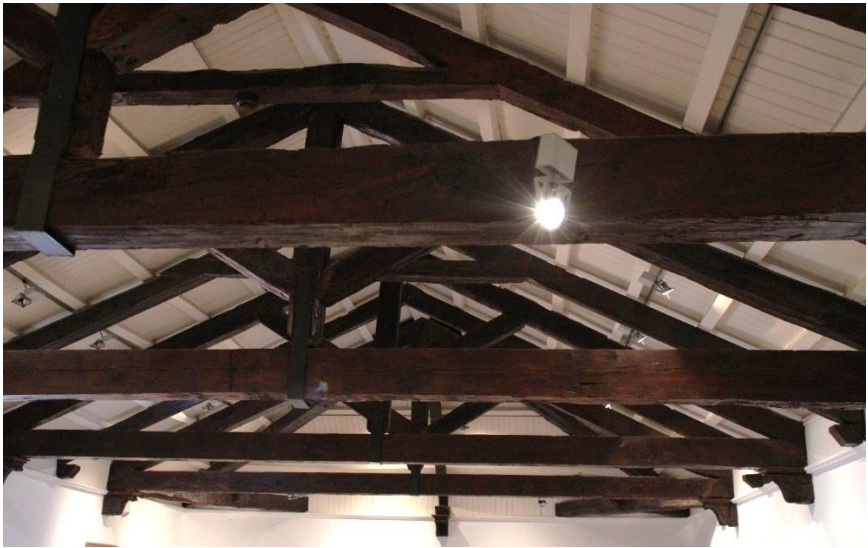
Imagen 7.1.10 Cubierta híbrida de cerchas y par y nudillo. Vista 1
