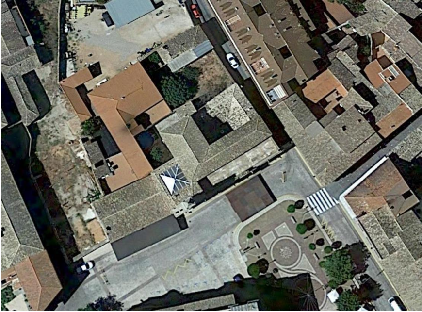
Imagen 2.1 Vista aérea del edificio. Propiedad de Google Earth.
