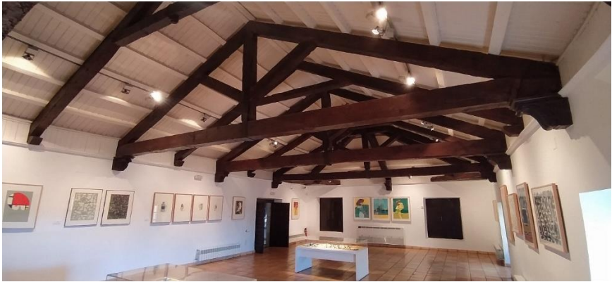
Imagen 2.2.5 Sala principal de la última planta.
