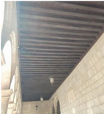
Imagen 7.1.7 Forjado del porche de siete vanos de la planta baja
