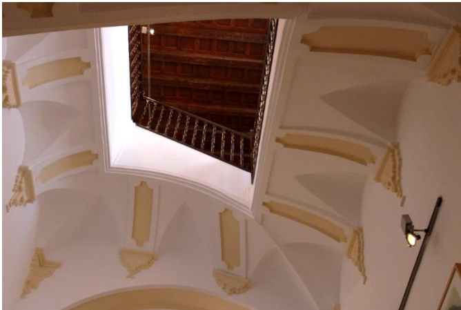
Imagen 7.1.19 Escalera de lunetos. Vista 2
