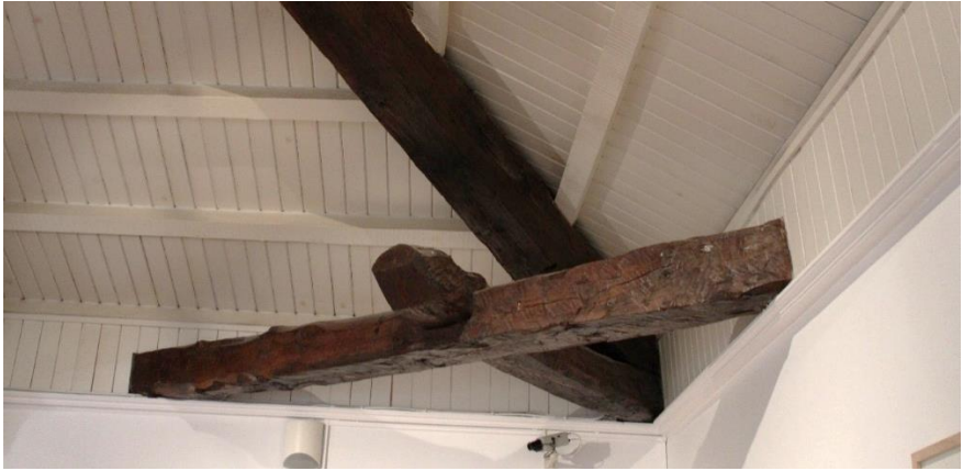
Imagen 7.1.13 Solución de las esquinas de la cubierta de madera.
