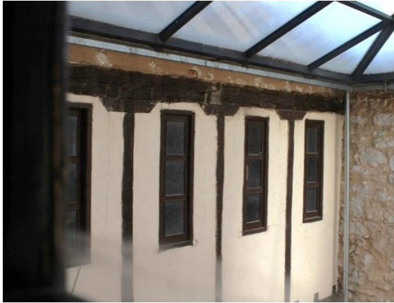
Imagen 7.1.16 Cubierta de policarbonato. Vista 2
