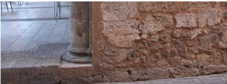
Imagen 9.1.10 Zona inferior de la fachada noroeste
