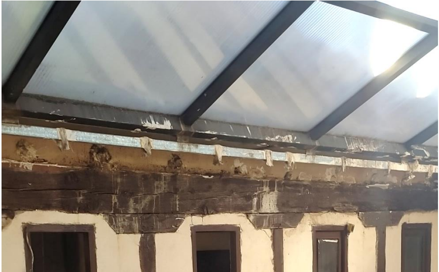
Imagen 9.1.3 Patio interior. Vista 1
