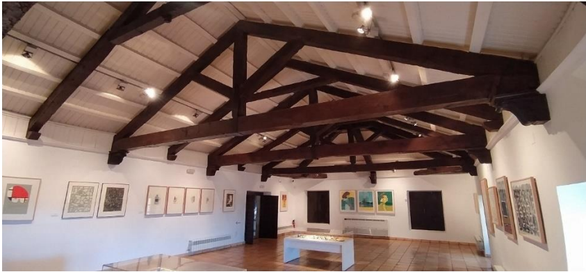
Imagen 7.1.11 Cubierta híbrida de cerchas y par y nudillo. Vista 2
