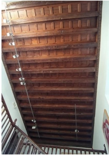
Imagen 7.1.6 Forjado de una de las estancias de la última planta.
