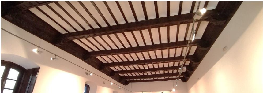
Imagen 7.1.8 Forjado de una de las estancias de la planta primera
