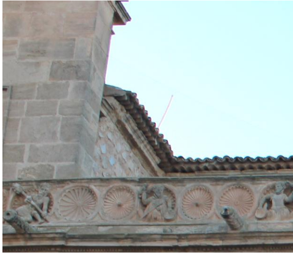
Imagen 9.1.11 Cornisa de la fachada principal
