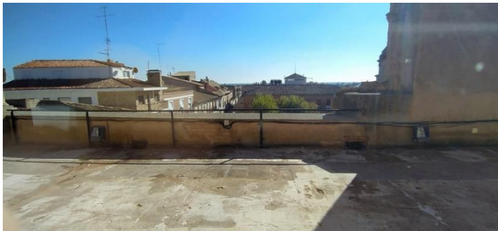
Imagen 9.1.2 Cubierta Plana. Vista 2
