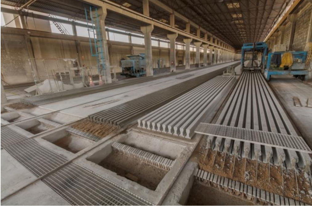
Figura 2. Fábrica de elementos de hormigón pretensado. Fuente: Empresa Preforsa.
