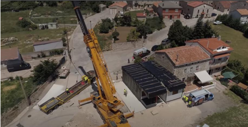
Figura 14. Grúa montando una vivienda modular. Fuente: Grupo Eurocasa.
