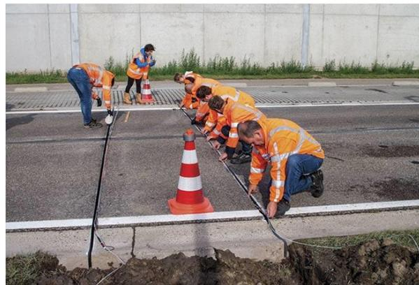
Figura 53. Sensor basado en fibra óptica y procedimiento de su instalación.
