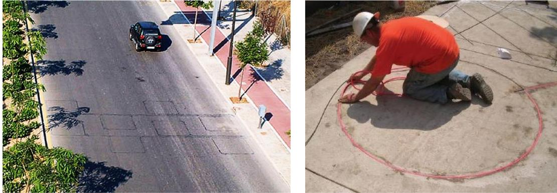
Figura 20. Las espiras electromagnéticas pueden tener distintas formas geométricas.
