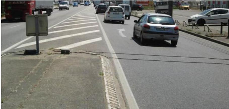
Figura 42. Despliegue en la calzada de un par de tubos neumáticos.
