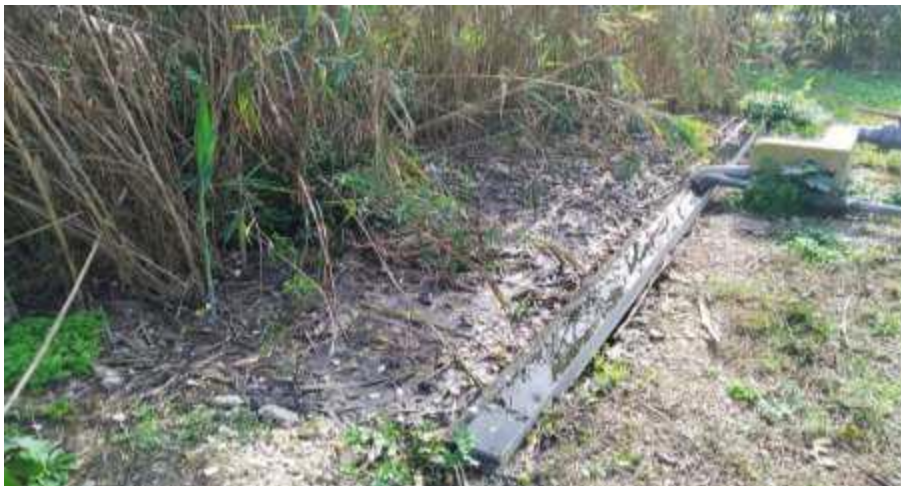
Figura 4. Entrada a los humedales en paralelo, donde se aprecia la zona inicial sin vegetación y el sistema de alimentación de ambos. Fuente: elaboración propia.
