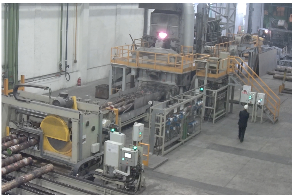
Figura 9: Foto instalación fundición.
