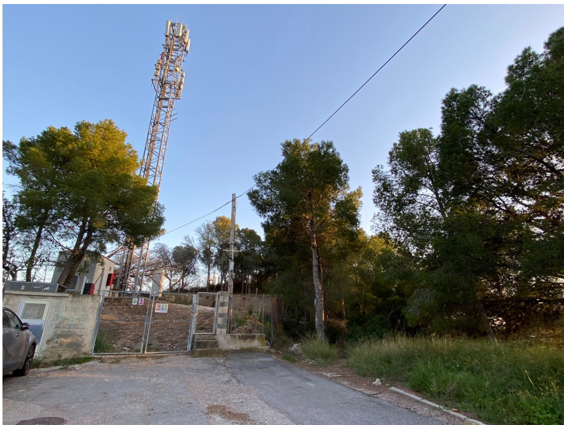
Ilustración 8. Estado en la zona de la torre de comunicaciones en la urbanización San Miguel. Abril 2022
