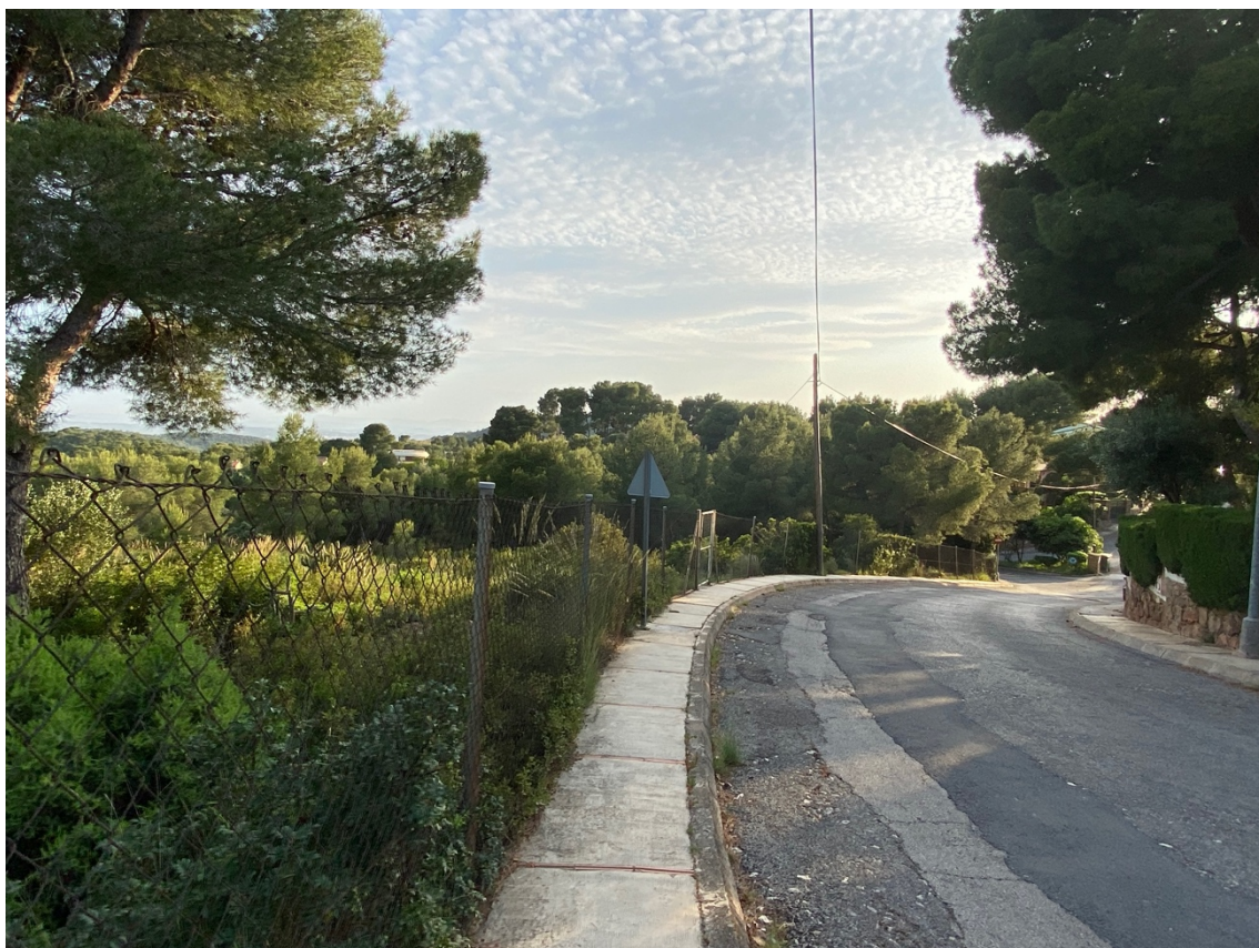
Ilustración 10. Estado del perímetro de la urbanización El Paraíso. Mayo 2022
