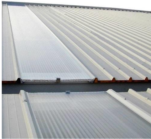
Ilustración 15. Lucernarios de policarbonato
