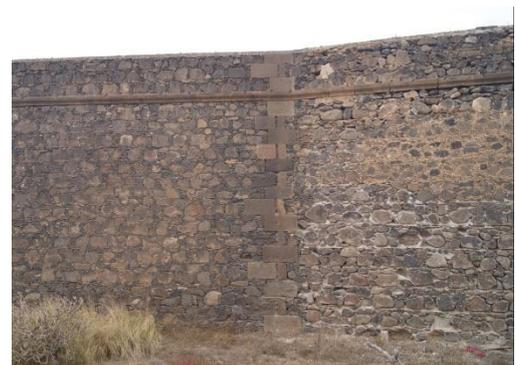
Fig. 32 Fotografía del encuentro de dos fases constructivas del alzado este/baluarte sur. 2021. Elaboración propia.
