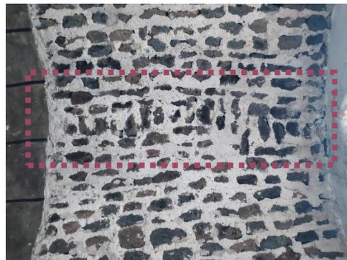
Fig. 136 Hiladas perpendiculares al resto de mampuestos en la zona de la clave.
