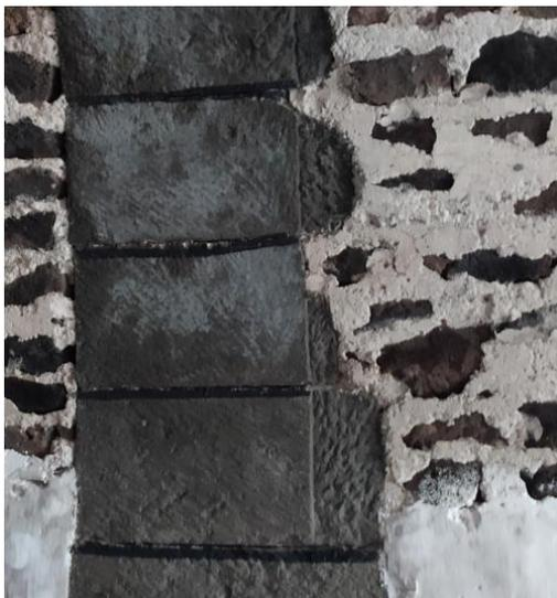
Fig. 133 Fotografía de detalle de sillares y mampuestos de la bóveda.
