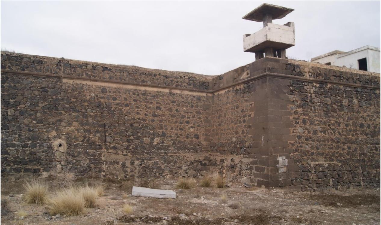
Fig. 39 Fotografía del flanco sur en el baluarte norte. En esta zona se observan trazas o vestigios de la antigua casa del Comandante y los muros que cercaban las huertas y tocaban los parapetos del castillo. 2021. Elaboración propia.
