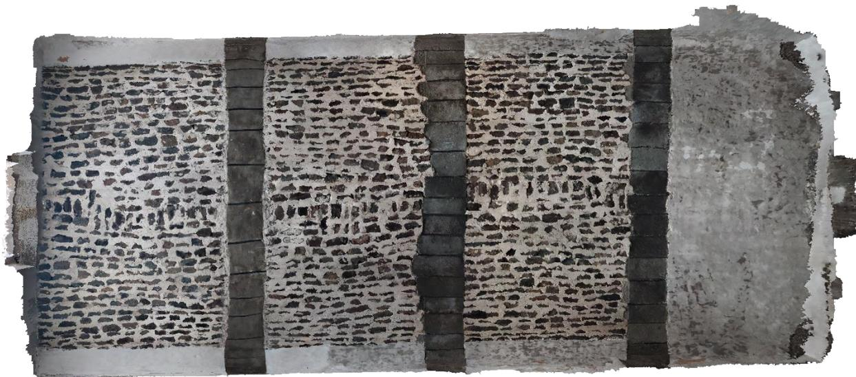
Fig. 132 Fotoplano de la bóveda. Levantamiento fotogramétrico actual del polvorín. Elaboración propia
