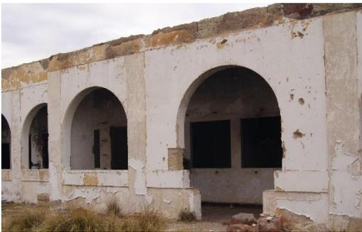
Fig. 120 Dormitorios de oficiales en explanada baja o patio de presos. Se aprecia el hormigón hidráulico y restos de diferentes colores de pintura en tonos rojizos y naranjas.
