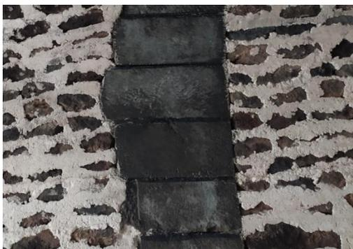
Fig. 134 Fotografía de detalle de sillares y mampuestos de la bóveda.
