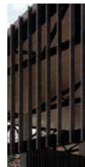
FACHADA Y CUBIERTAS
