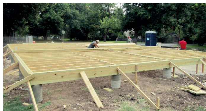
Ilustración 10. Cimentaciones sobre pilotes.
