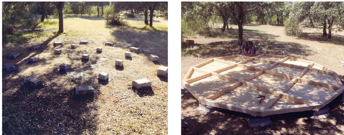
Ilustración 7. Cimentación de zapatas aisladas bajo forjado de madera.
