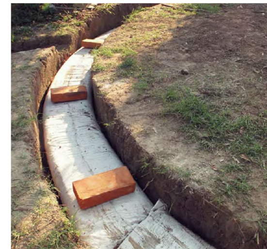
Ilustración 11. Cimentación con superadobe.
