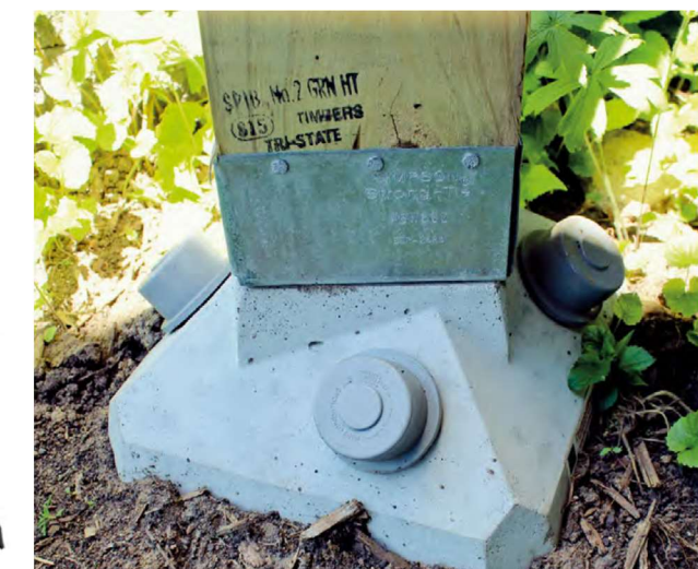
Ilustración 12. Zapatas desmontables.
