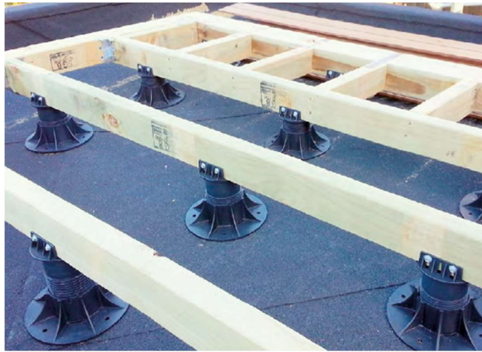
Ilustración 13. Cimentación tipo Plots.
