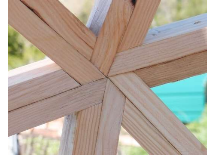
Ilustración 19. Sistema de unión carpintera Good Karma para domos geodésicos.
