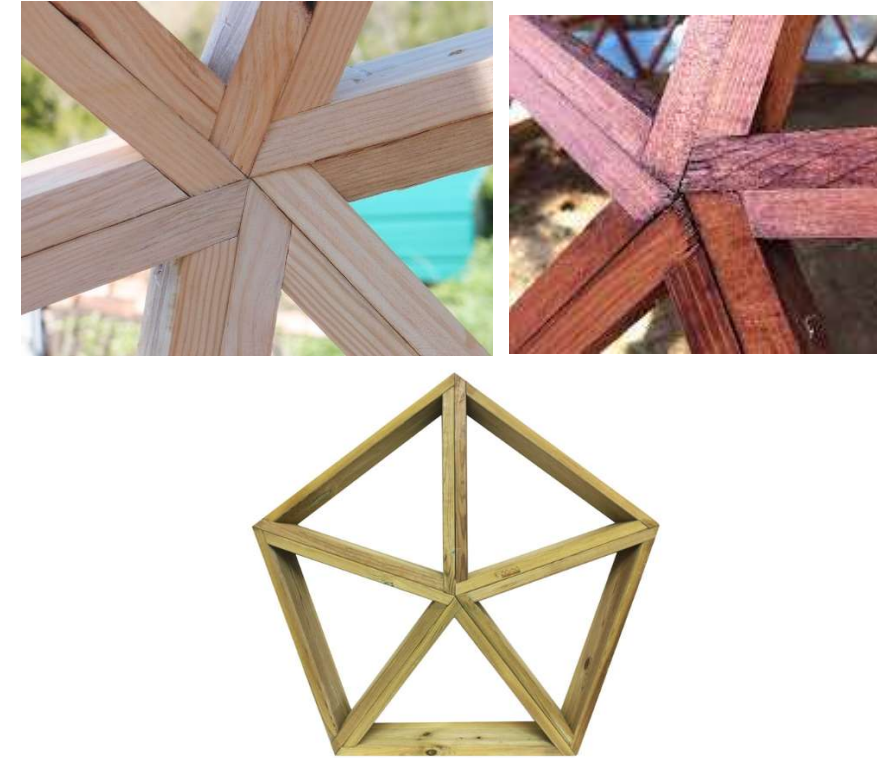
Ilustración 1. Ejemplo de uniones tradicionales Good Karma.
