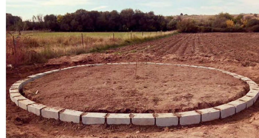
Ilustración 8. Muro de bloques de hormigón sobre zapata corrida circular.
