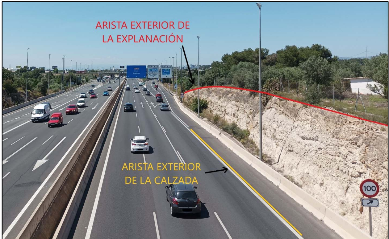
Foto 13. Aristas de referencia en un tramo de la autovía CV-35 Fuente: Elaboración propia
