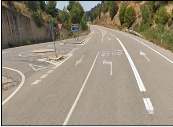
Foto 9. Carril de espera central en la N-III Fuente: Google Earth
