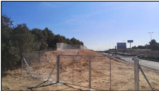
Foto 22. Vallado de cerramiento Fuente: Autovía del Turia
