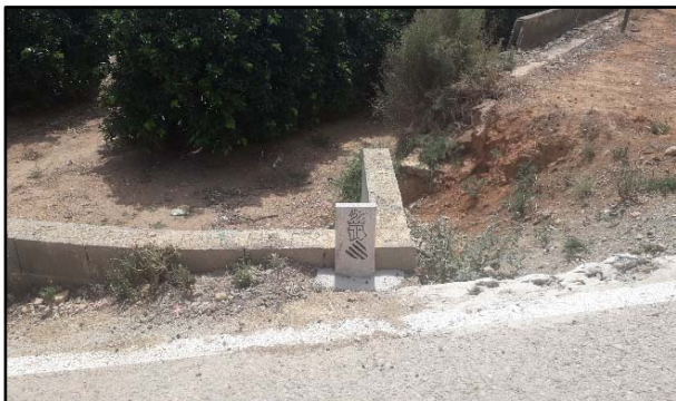
Foto 24. Mojón delimitador tipo rigola Fuente: Autovía del Turia
