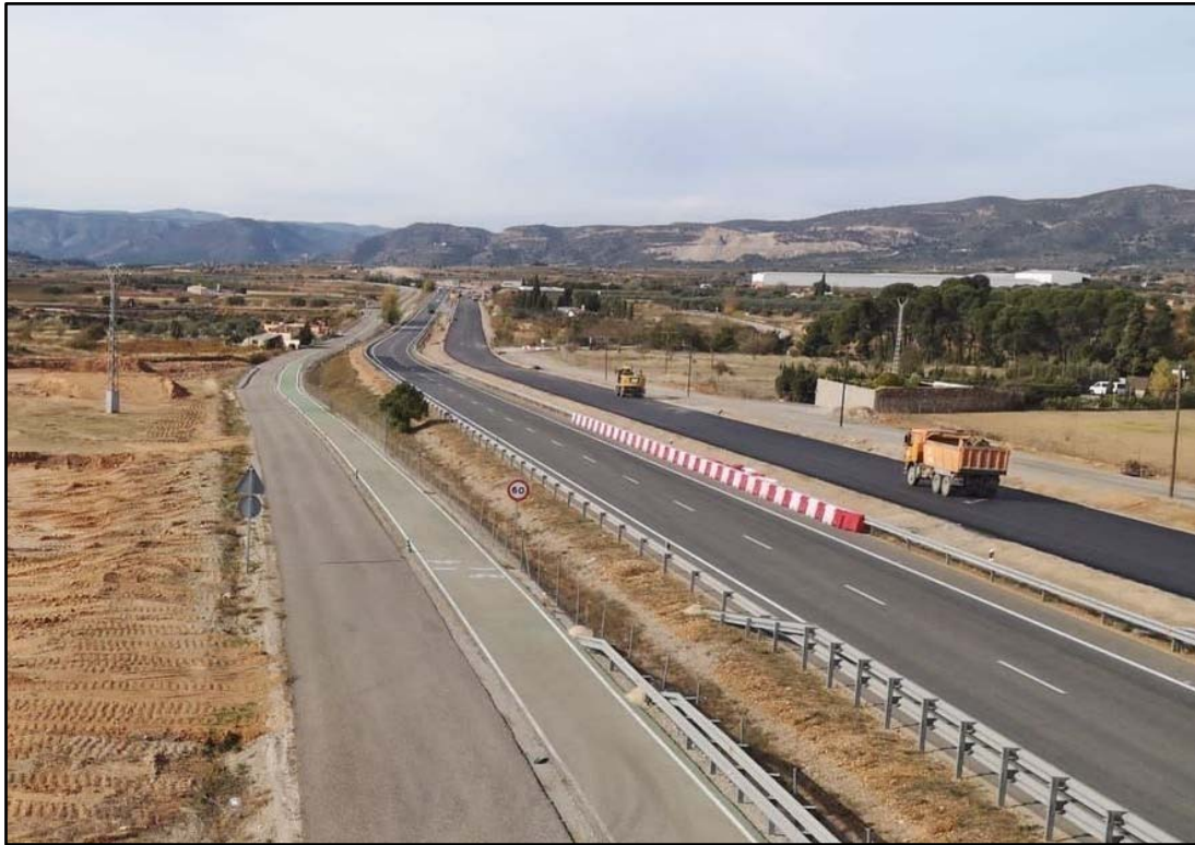
Foto 20. Vía de servicio y carril bici de la CV-35 Fuente: Autovía del Turia
