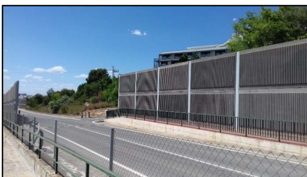
Foto 18. Pantallas acústicas en la CV-35 Fuente: Elaboración propia
