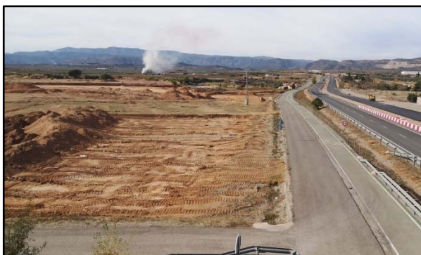
Foto 3. Obras colindantes Fuente: Autovía del Turia
