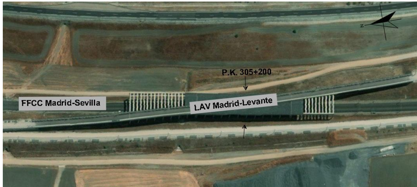
Figura 2. Emplazamiento Pérgola P.K. 305+200. (Fuente: (Ferrero, Yepes, & Alcalá, 2020)).
