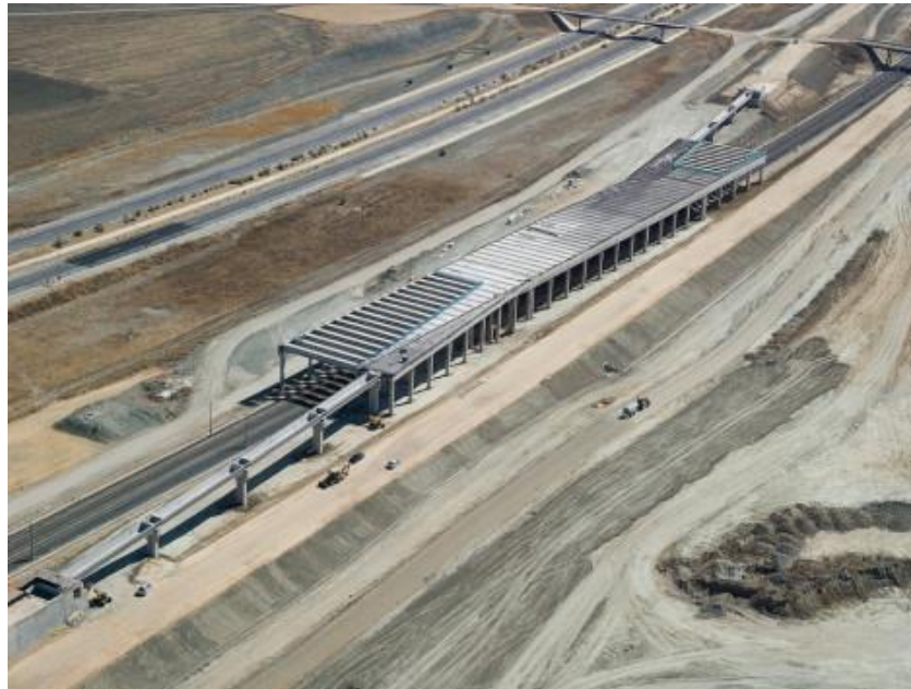
Figura 8. Emplazamiento Pérgola P.K. 305+200. (Fuente: (Ferrero, Yepes, & Alcalá, 2020)).
