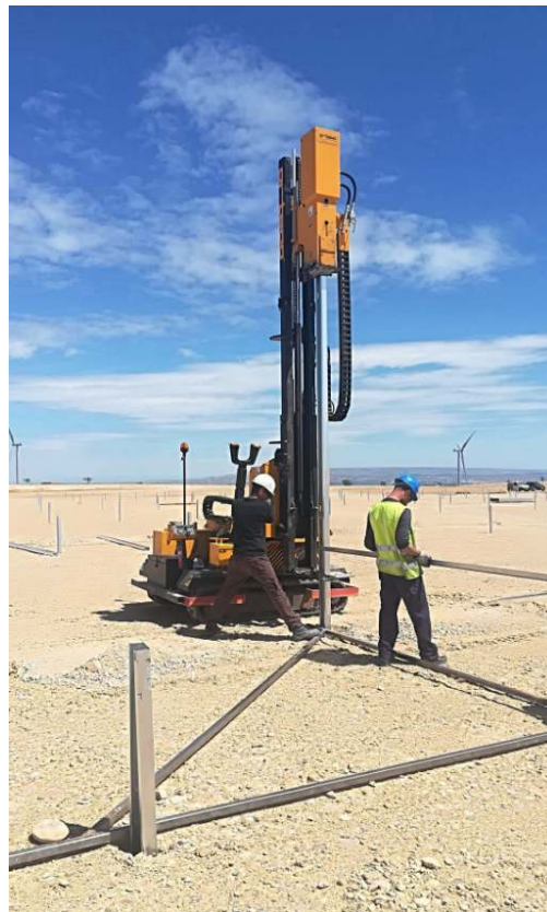
Figura 16 Mètode de clavat de perfils en el terreny [6]
