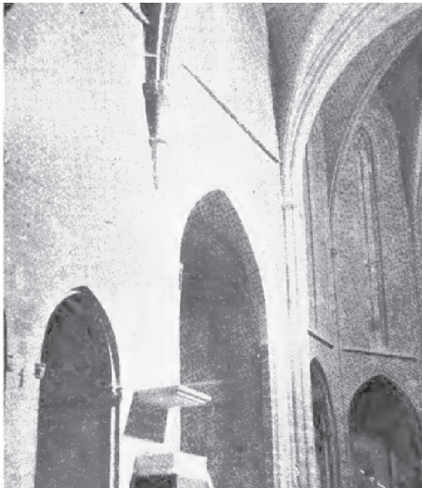
Fig. 27. Capillas laterales (Puig, 1954, Lám. IX)
