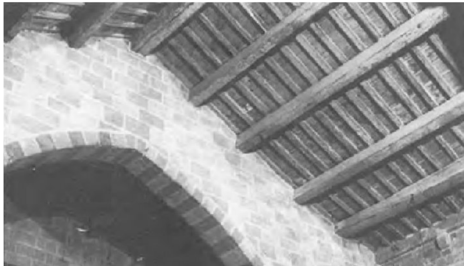
Fig. 64. Arco diafragma y techumbre de madera (Constante y Lara, 1984, p.26)
