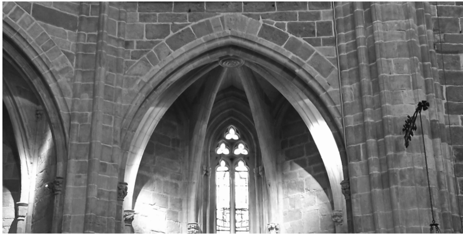
Fig. 114. Arco formero de la entrada a la capilla (imagen propia)
