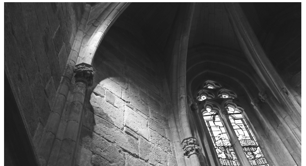
6. Bóveda de crucería radial de la capilla de San Vicente Ferrer de la Iglesia Arciprestal de Sant Mateu
