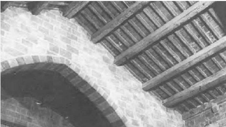
Fig. 26. Arco diafragma y techumbre de madera (Constante y Lara, 1984, p.26)
