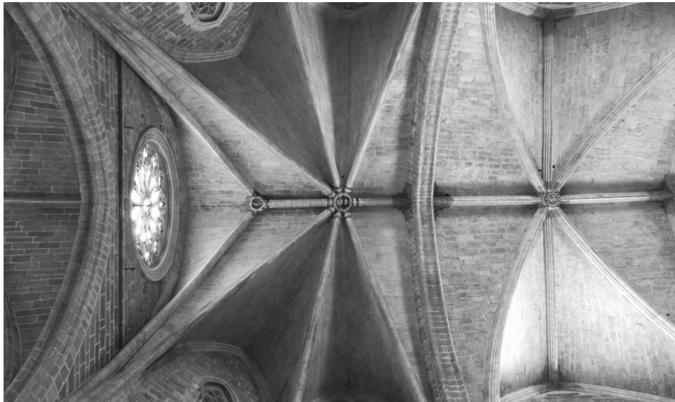
Fig. 37. Bóveda del ábside de la iglesia arciprestal (imagen propia)
