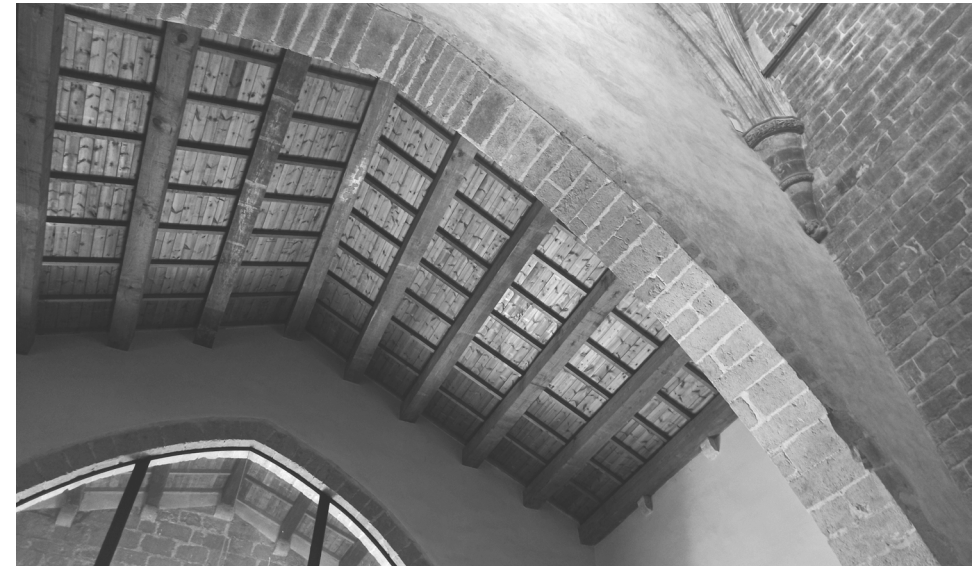
Fig. 84. Techumbre de madera. Arcos diafragma a los pies de la iglesia (imagen propia)
