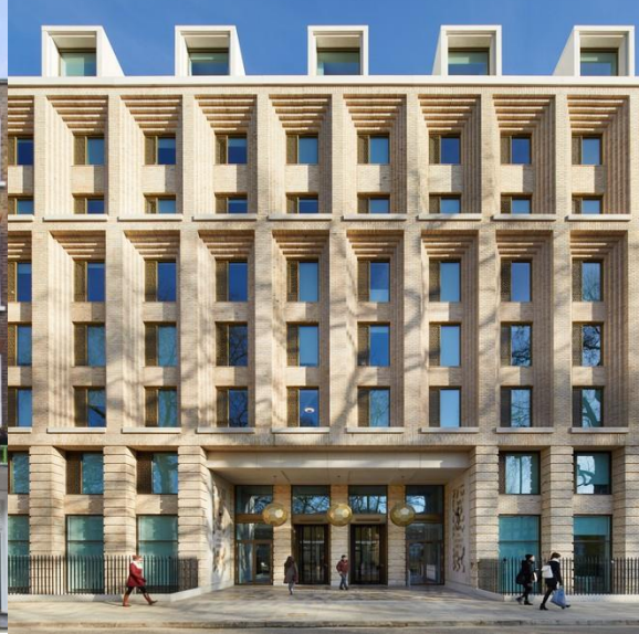
Figura III.69. Fachada principal, con el ático y sus potentes elementos prefabricados donde se ubican los ventanales, revestidos de terracota vidriada blanca
