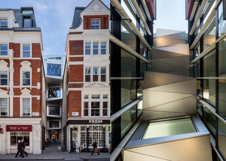
Figura III.56. Fachada Exterior desde Chancery Lane
