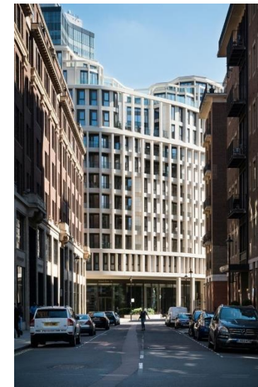
Figura II.10. Afortunadamente, cada vez hay más ejemplos de bloques de vivienda, y proyectos contemporáneos como Abell y Cleland, de DSDHA, en Westminster , reinterpretan hábilmente los motivos tradicionales de la vivienda londinense, como los patios, la comunalidad y los balcones, para establecer una forma contemporánea de vivienda de alta densidad que sea respetuosa con el patrimonio y el carácter de la ciudad -véase Vivienda-.
