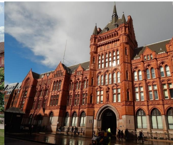
Figura II.140. Holborn Prudential Assurance Building, de finales del XIX, en un estilo neogótico victoriano de terracotta
