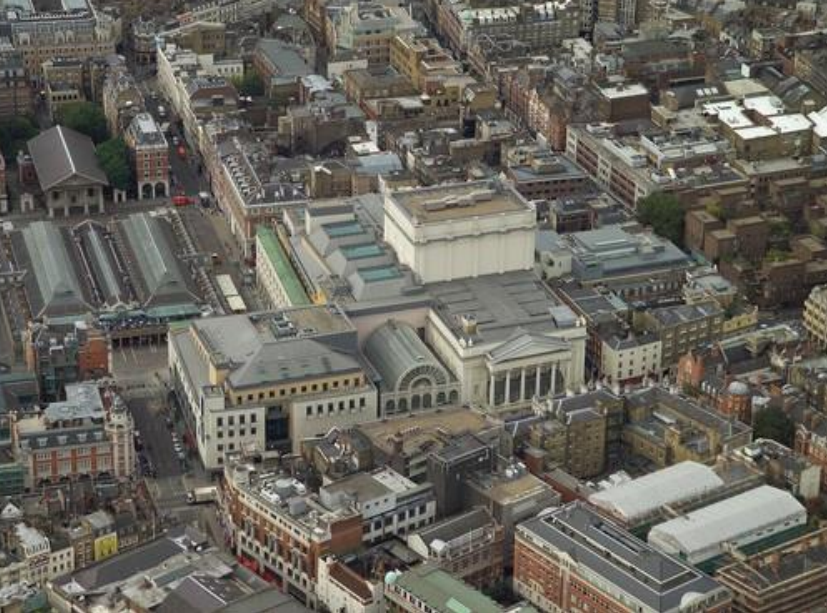
Figura II. 198. Vista aérea de la Covent Garden Piazza detrás de la Royal Opera House
