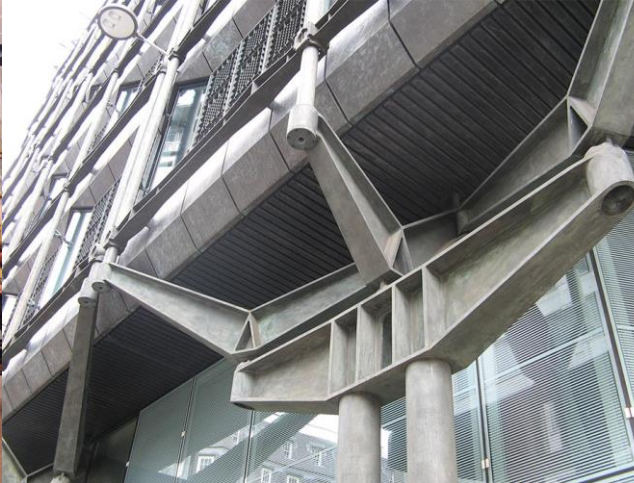
Figura III.50. En este caso, las varillas se agrupan en pilares más gruesos en su base y se apoyan en ménsulas cuidadosamente suspendidas que forman una columnata poco profunda
