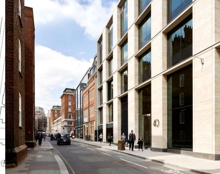
Figura III.62. Con fines monumentales, en el alzado principal en Chancery Lane, estos elementos estructurales se dan en intervalos de 6 metros
