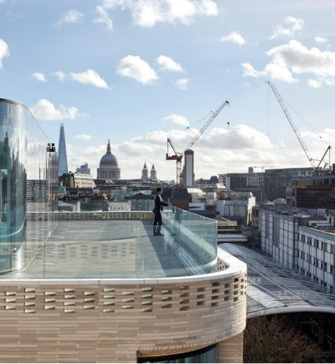
Figura III.42. Para enfatizar la ligereza del cuerpo superior, la planta se encuentra más retrasada respecto al perímetro -es más pequeña- lo que permite al arquitecto crear una cinta continua de terraza exterior con un balcón que rodea el borde del edificio
