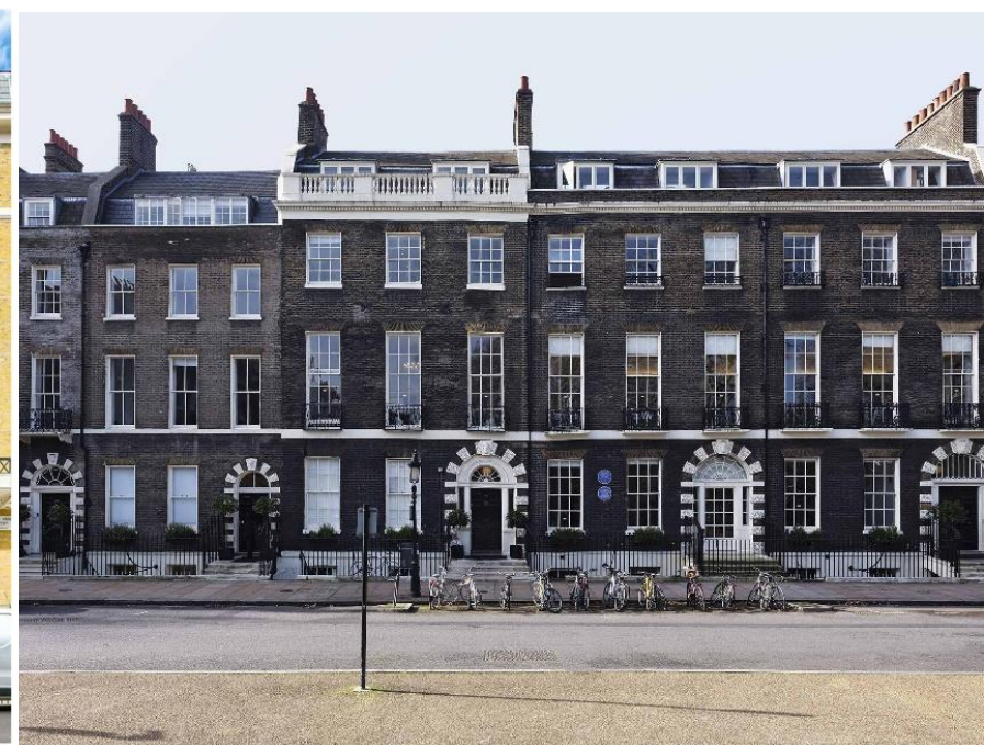
Figura II. 131. Terrazas georgianas en Bloomsbury de tono grisáceo ennegrecido del London Stock Brick decolorado con el paso del tiempo.
