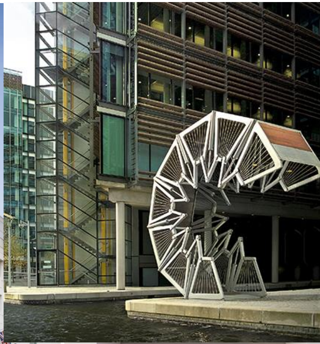
Figura II. 177. The Rolling Bridge de Thomas Heatherwick, un puente plegable con un complejo sistema móvil que lo abre y lo cierra como si de una goma flexible se tratase.
