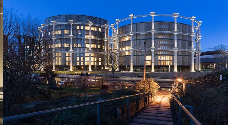
Figura III.93. Exterior de los Gasholders, con los bidones residenciales dentro de la estructura victoriana original
