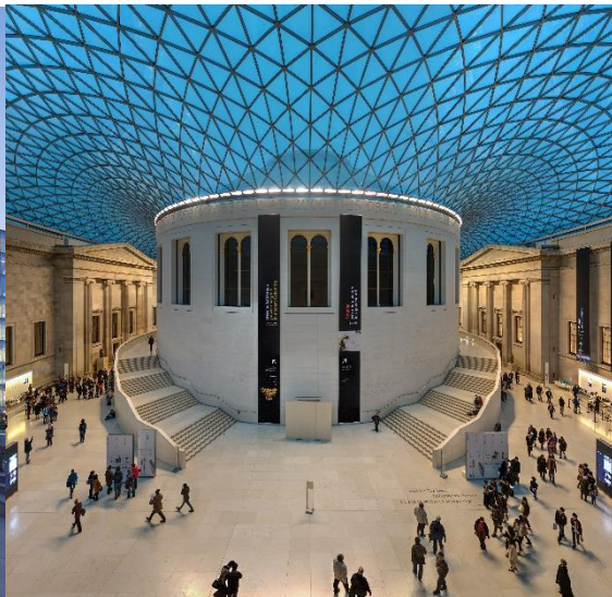
Figura II.162. The Great Court en el British Museum, con su majestuosa cubierta de vidrio y acero formada con los característicos diagrids de Foster.
