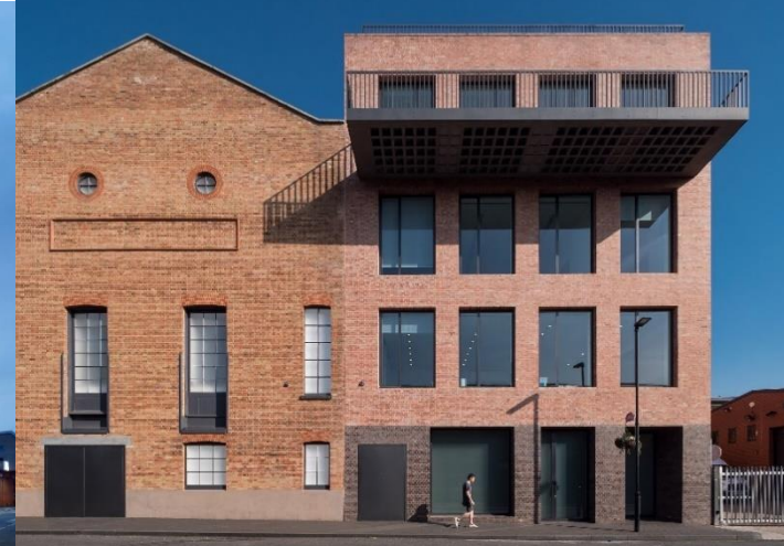
Figura III.79. Presenta una composición exterior muy racional y simple, bajo un poderoso balcón superior de hormigón en voladizo
