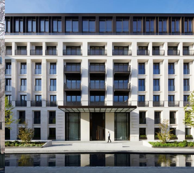
Figura III.17. Fachada del edificio 2 con el acceso al vestíbulo presidiendo el cuerpo bajo.
