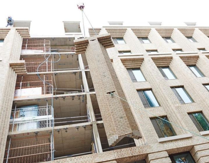
Figura III.72. La fachada está formada por una serie de pilares y paneles prefabricados de hormigón, como unidades individuales de tres pisos de altura en forma de 'T' alargadas, ensamblados fuera de la obra y revestidos con el acabado de ladrillo
