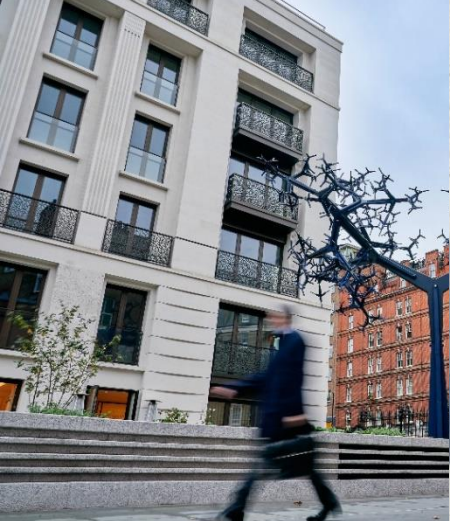
Figura III.21. Base rusticada y balcones empotrados con un perfil metálico en la columna
