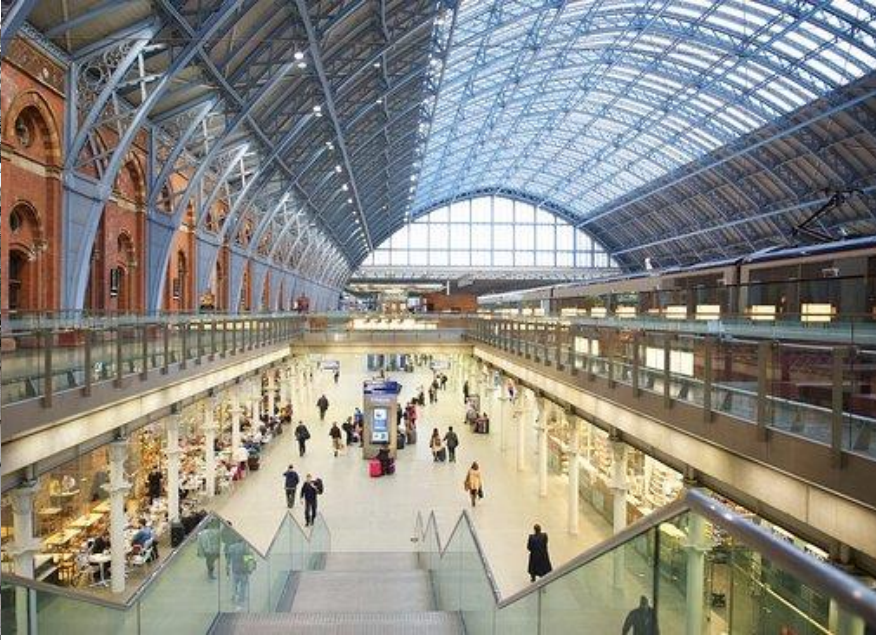
Figura II. 142. Interior de la Estación de Saint Pancras hacen- además- uso del vidrio y del acero, muy vinculado a la Revolución industrial y la era del ferrocarril, enormes cubiertas que combinan el Acristalamiento insertado en extravagancias de hierro fundido o forjado
