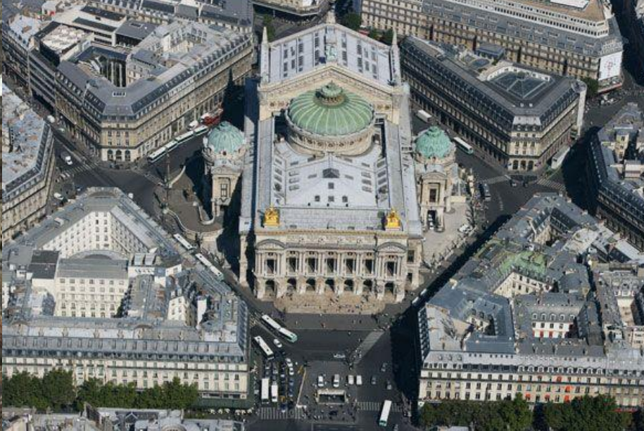
Figura II. 199. Vista de pájaro del Palais Garnier frente a la Place de l'Opéra, subyugando las calles circundantes a un encrucijado
