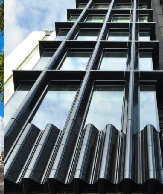
Figura II.136. Make Architects ha usado recientemente la terracotta en London Wall para enmarcar la composición de la fachada
