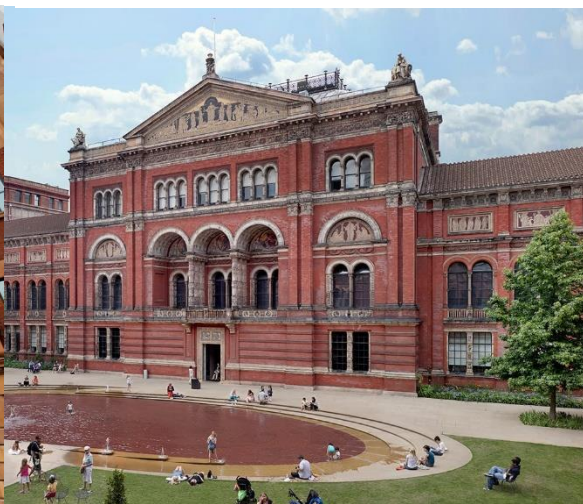
Figura II.139. Patio trasero del Victoria and Albert, en estilo Italianizante de ladrillo rojo.
