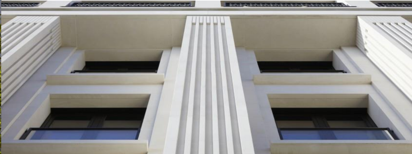
Figura III.27. En los tramos secundarios hay unos balcones de tipo Juliette con superficies acristalados dentro de un marco de aluminio anodizado de bronce
