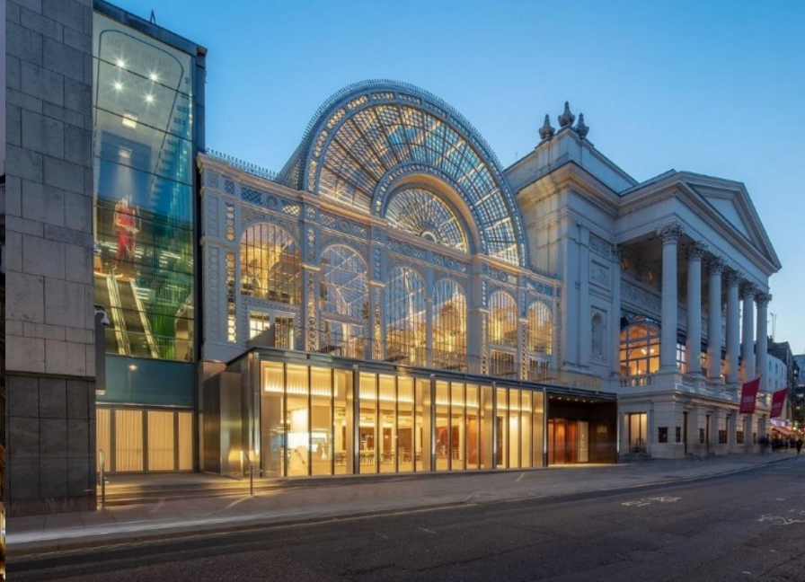
Figura II. 196. La Royal Opera House mantiene su recóndita presencia en Bow Street
