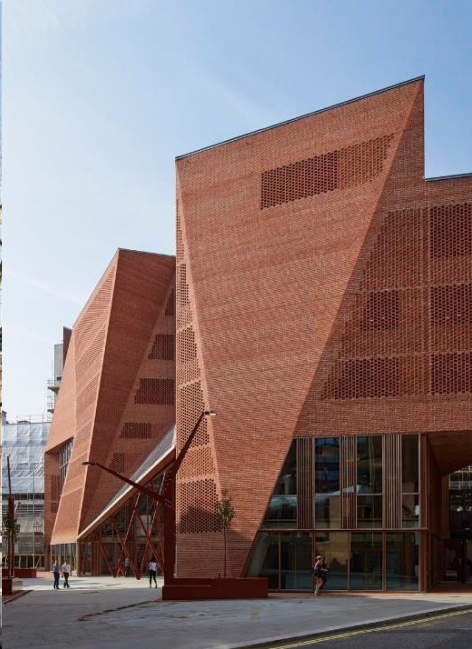
Figura II.134. Saw Swee Hock LSE Student Centre (2014), O'Donnell + Tuomey, ejemplo contemporáneo de fábrica de ladrillo rojo, explora las formas a partir de la fachada ventilada.
