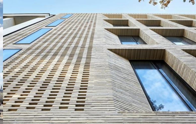
Figura III.41. Los huecos de las ventanas son profundos y achaflanados en planta
