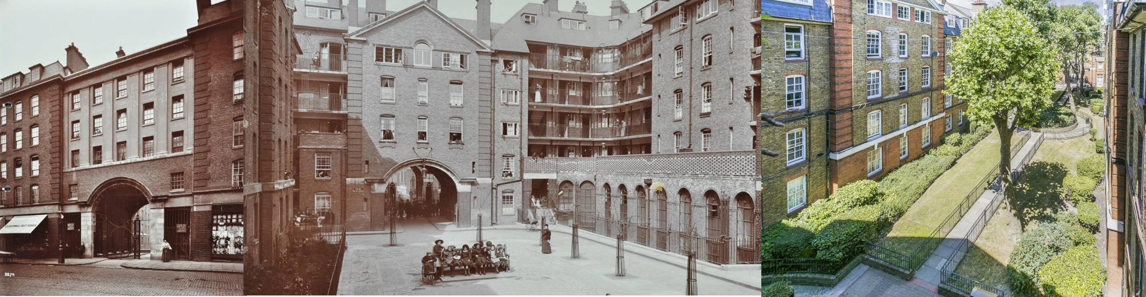
Figura II. 107. 108. 109. Con sus patios protegidos rodeados de balcones privados y con acceso a la cubierta, a los que se entraba a través de una secuencia de arcos formales, los complejos de vivienda social emblemáticos como la de Bourne, en Clerkenwell (recientemente reformada), presentaban un modelo muy civilizado de vivienda social urbana masiva basado en los mismos principios de comunalidad individualizada que definen la terraza, pero con un énfasis más pronunciado en la comunidad y la interacción. (Ijeh, 2020)
