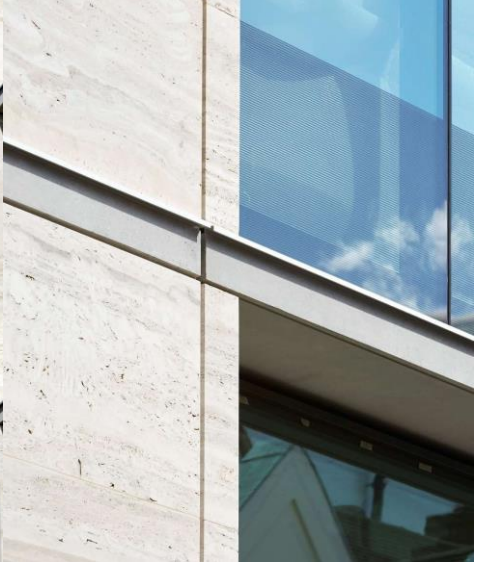
Figura III.67. Alfeizares prefabricados y juntas del travertino
