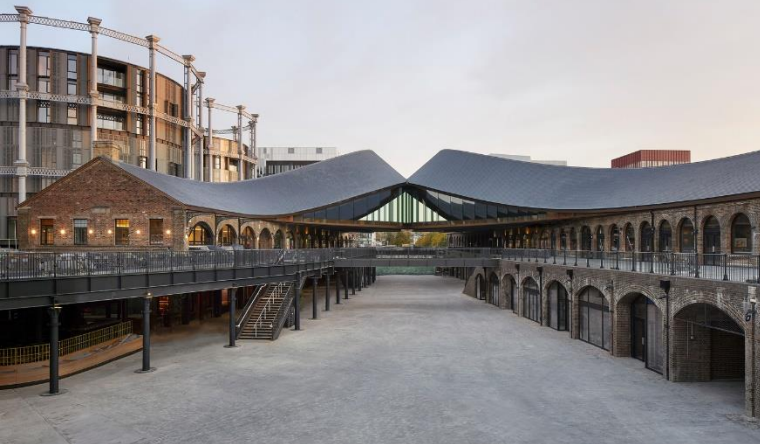
Figura III.94. Coal Drops Yard, espacio comercial sobrevuela el espacio público
