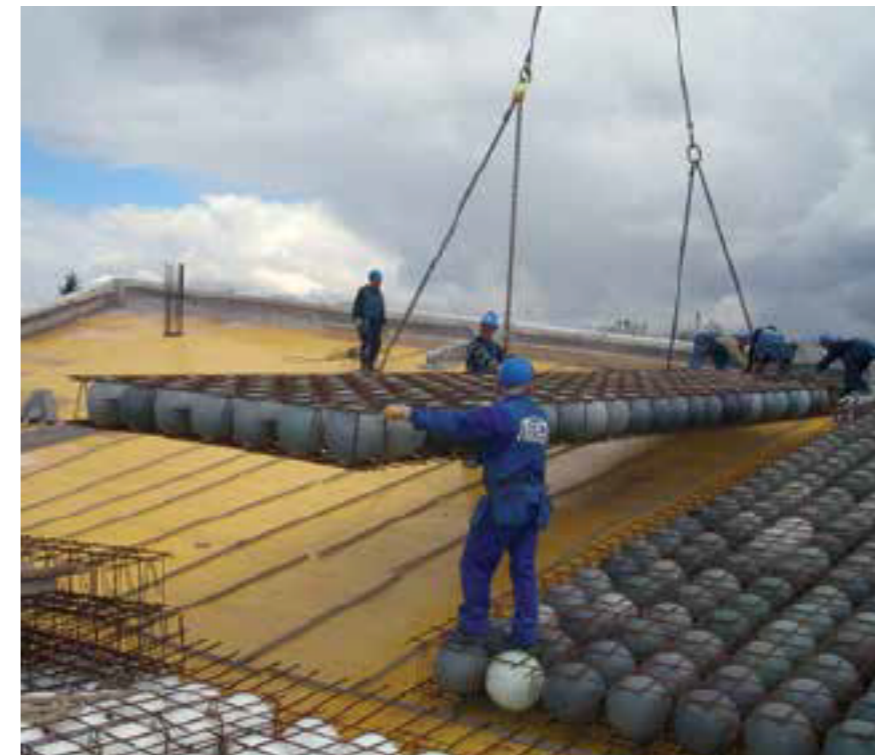
Montaje BubbleDeck
