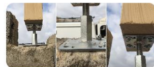
3.3. NTE-EMS Pilares de Madera 7 Pines
