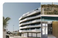
10. Obras Terminadas 19 Pines · 2 subtableros 4 sem
