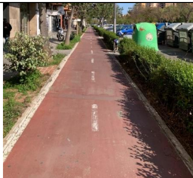
Figura 82. Pavimento de hormigón
