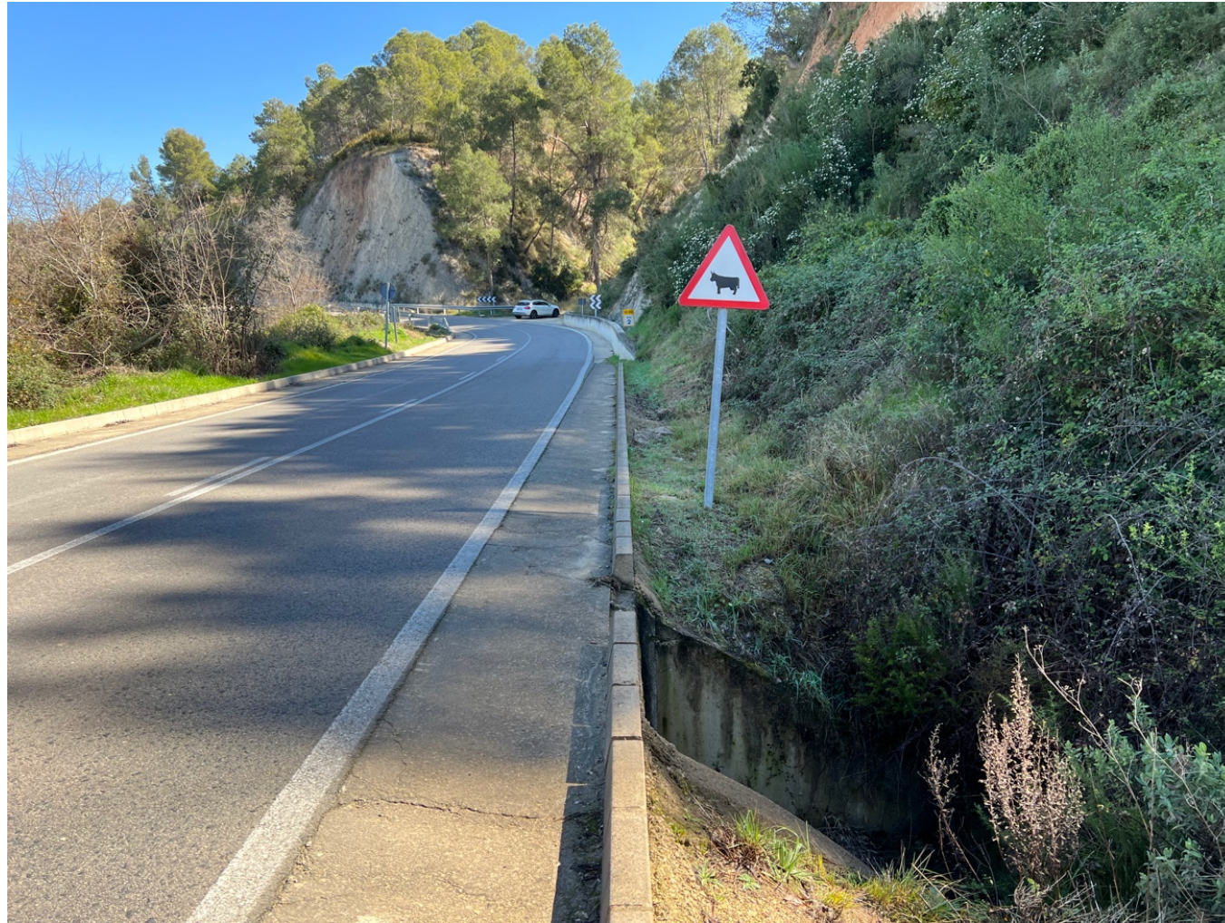
Ilustración 22. Obra de drenaje transversal. Fuente: Elaboración propia.
