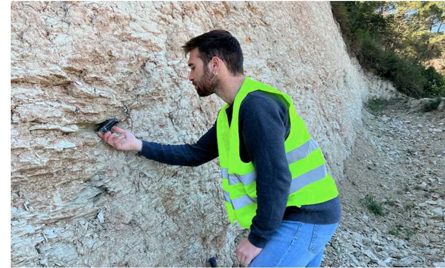
Ilustración 27. Planos de exfoliación en la zona de la berma. Fuente: Elaboración propia.
