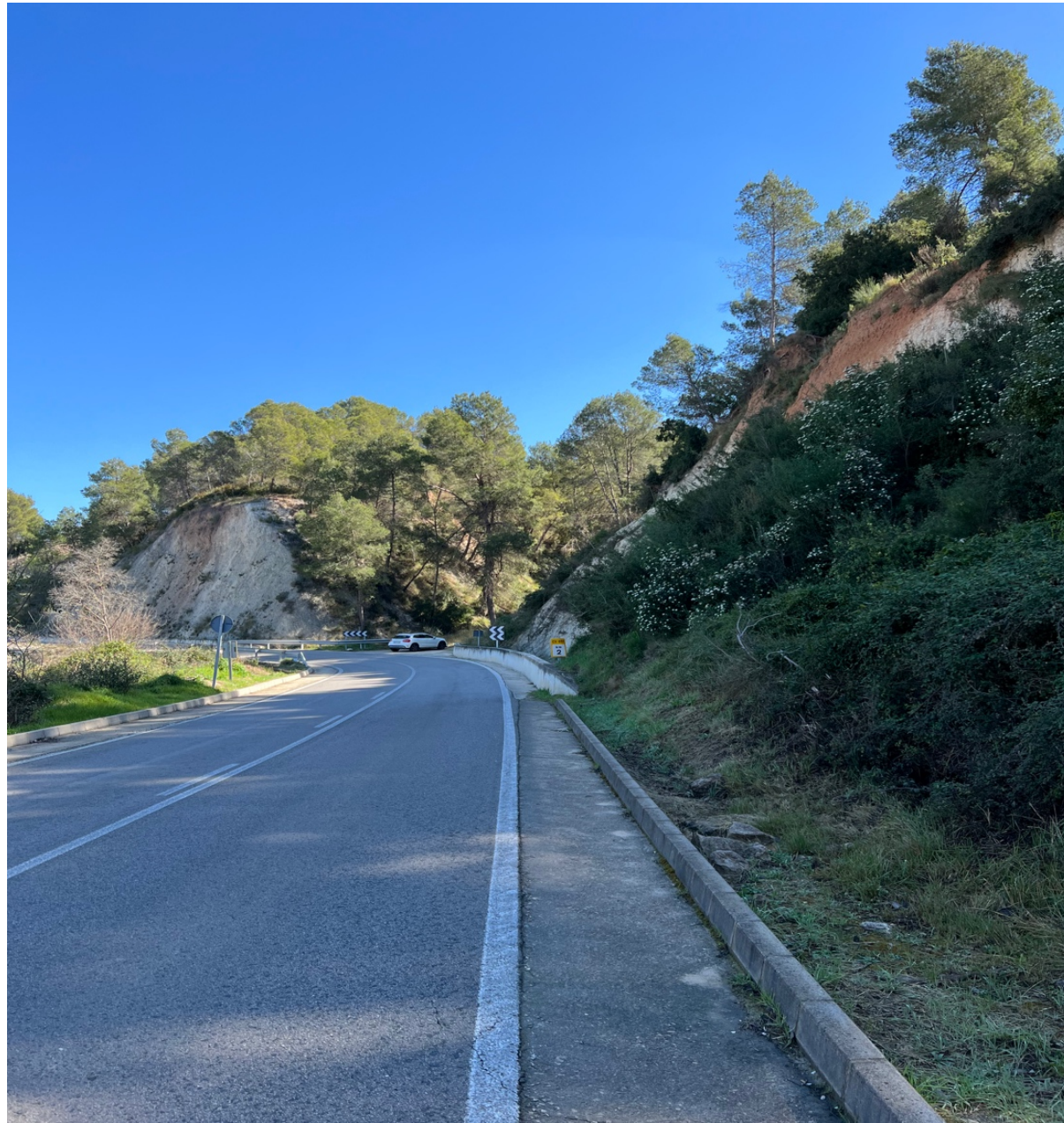
Ilustración 20. Cuneta longitudinal a lo largo de la CV-652. Fuente: Elaboración propia.
