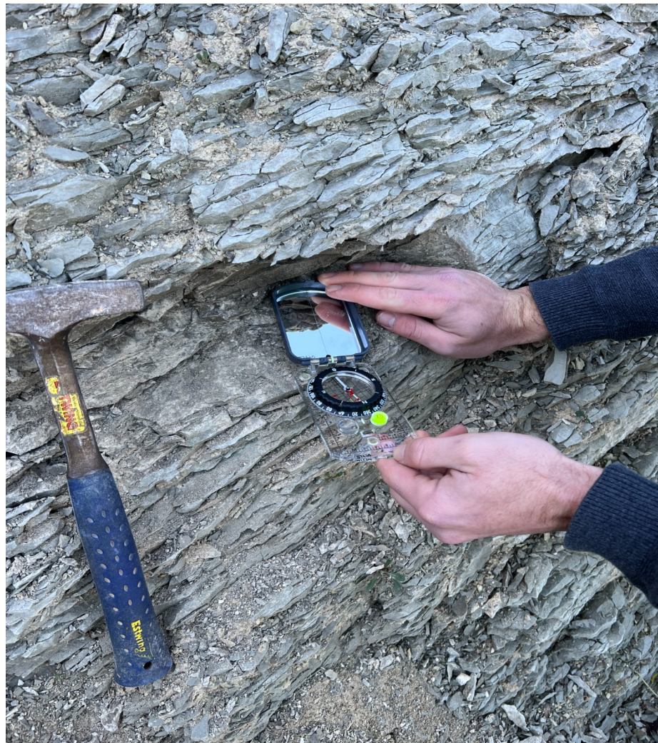
Ilustración 26. Planos de exfoliación en el pie del talud. Fuente: Elaboración propia.
