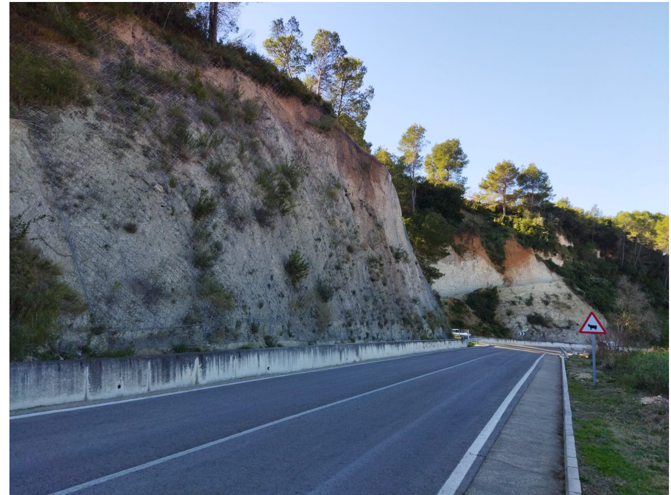
Ilustración 13. Imagen general de ambos taludes. Fuente: Elaboración propia.
