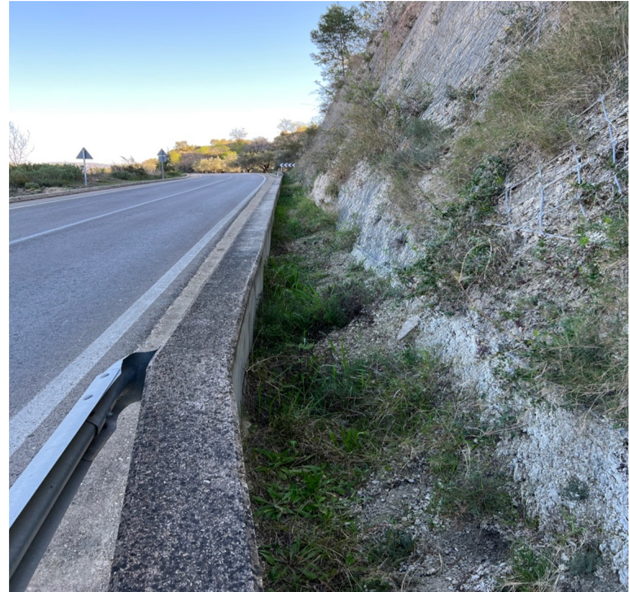
Ilustración 15. Muro de protección al pie del talud del P.K. 1+950. Fuente: Elaboración propia.
