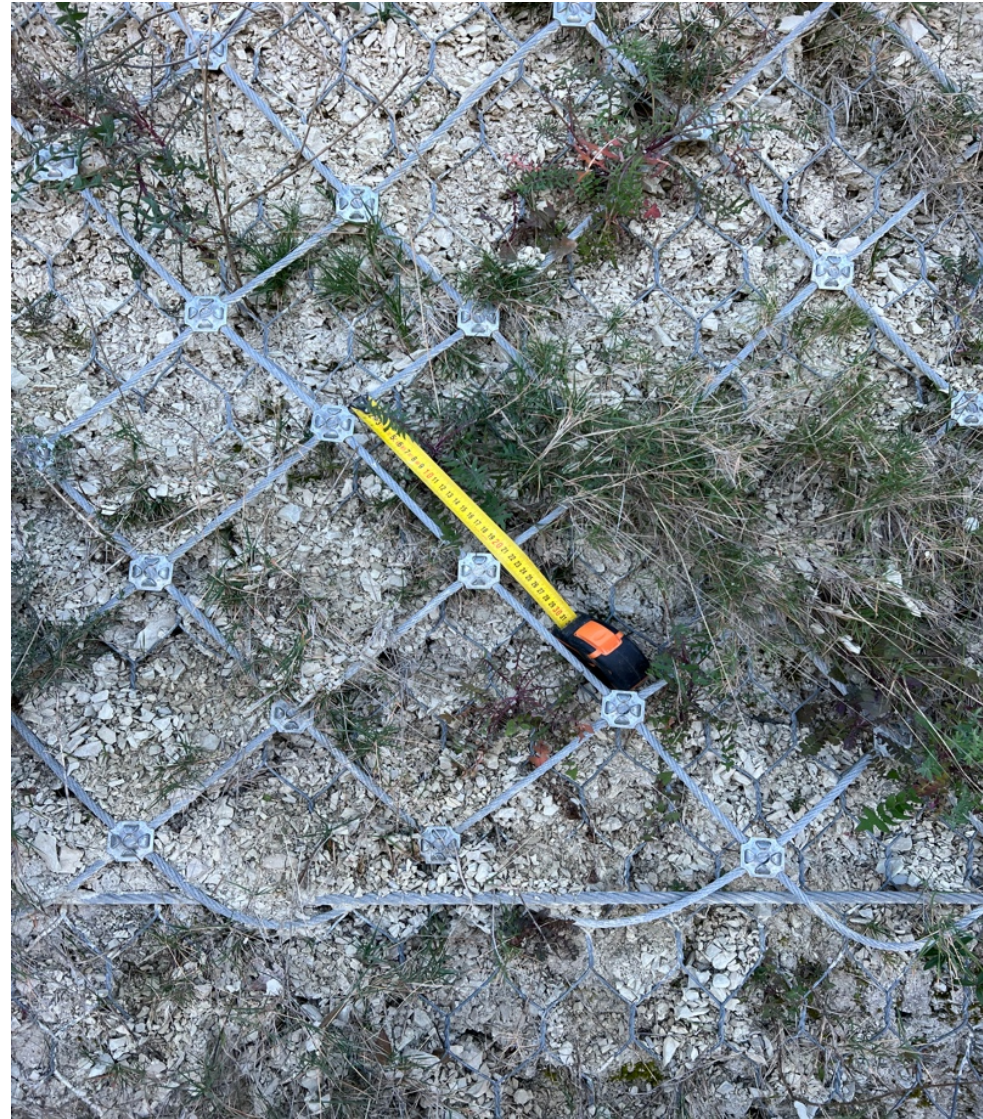
Ilustración 16. Malla de protección del talud del P.K. 1+950. Fuente: Elaboración propia.
