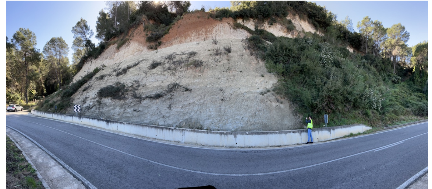
Ilustración 17. Talud del P.K. 2+000. Fuente: Elaboración propia.
