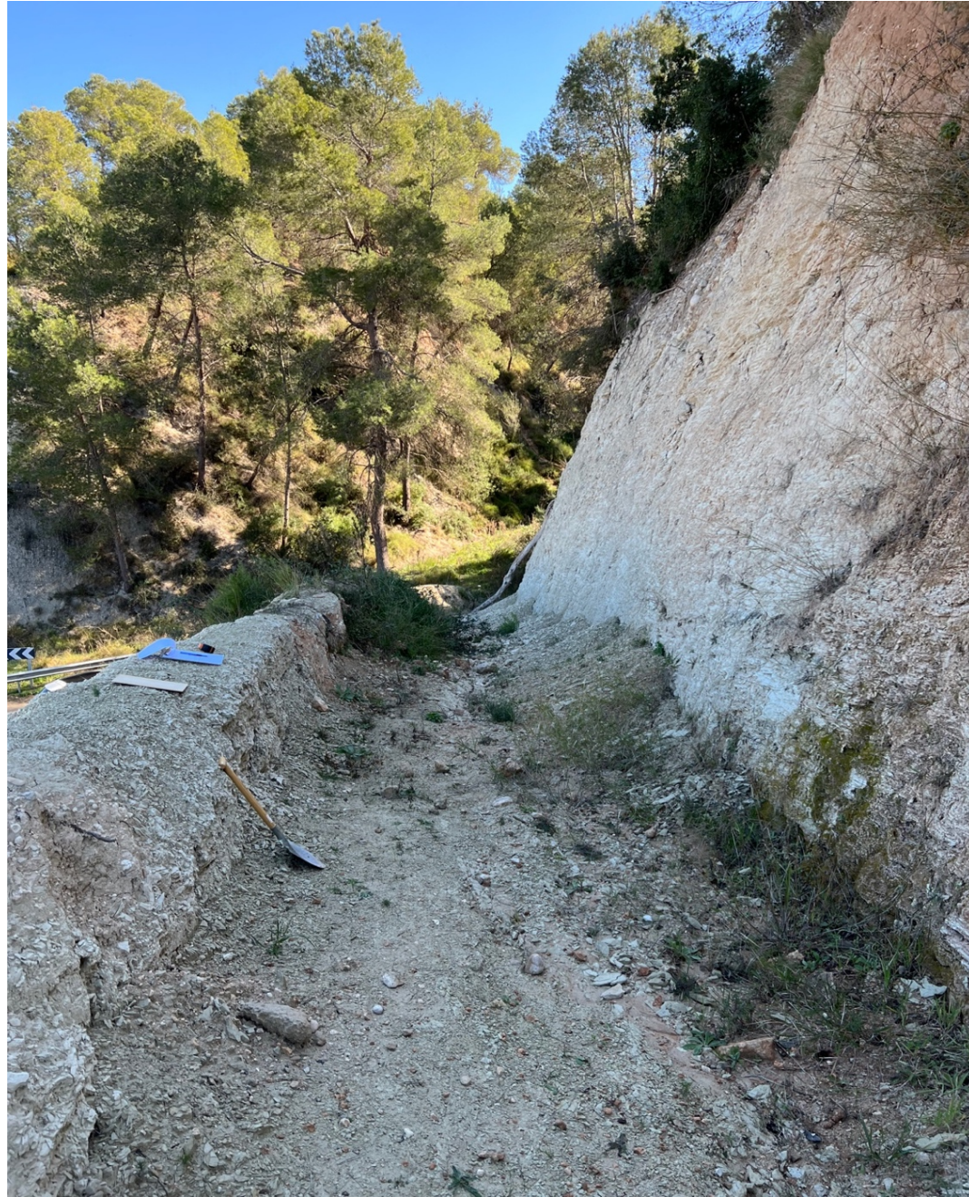
Ilustración 31. Berma, solución provisional ejecutada. Fuente: Elaboración propia.
