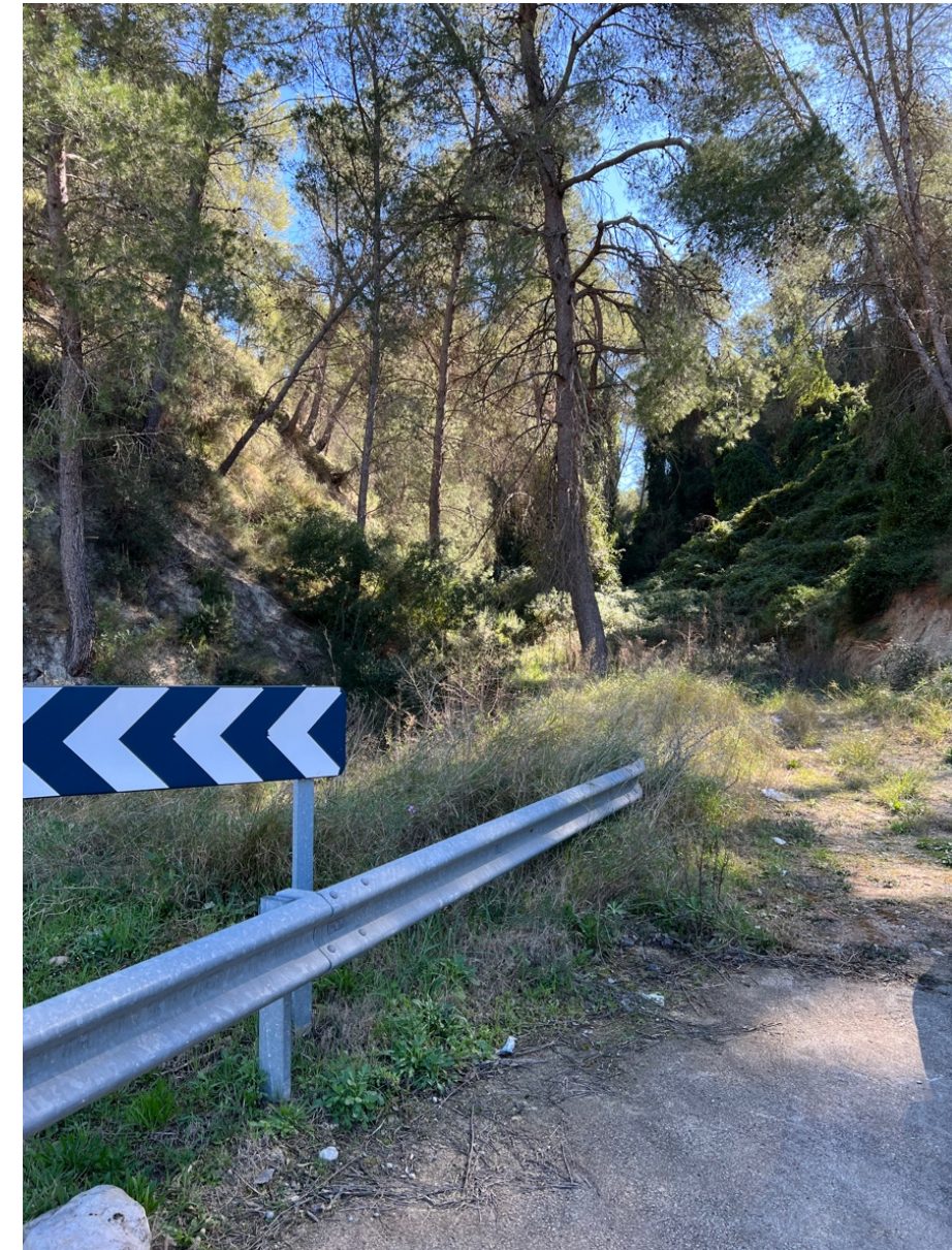
Ilustración 23. Barranco entre ambos taludes. Fuente: Elaboración propia.
