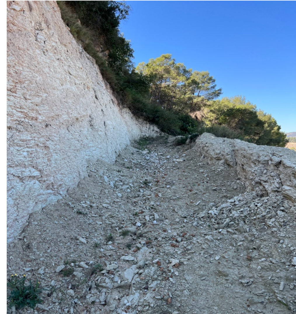
Ilustración 19. Berma a mitad talud del P.K. 2+000. Fuente: Elaboración propia.
