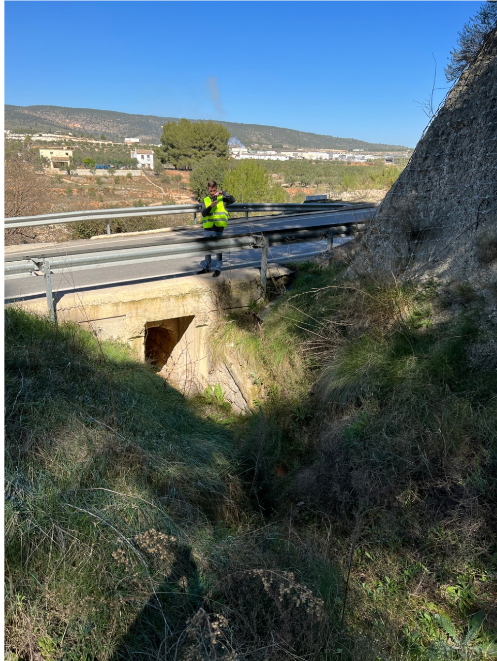
Ilustración 24. Obra de drenaje transversal entre ambos taludes. Fuente: Elaboración propia.
