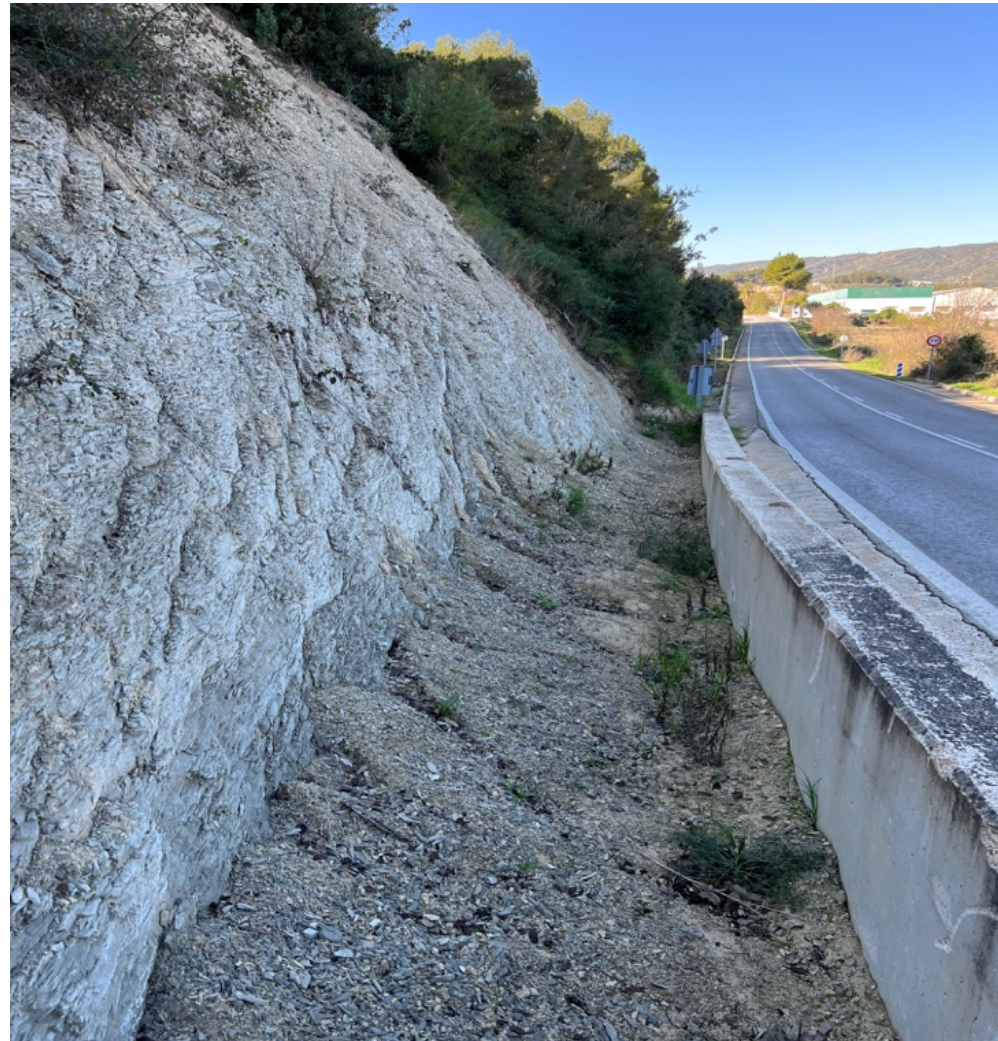
Ilustración 18. Muro de protección al pie del talud del P.K. 2+000. Fuente: Elaboración propia.
