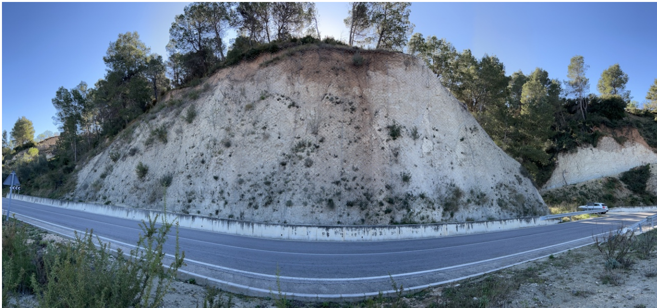
Ilustración 14. Talud del P.K. 1+950. Fuente: Elaboración propia.
