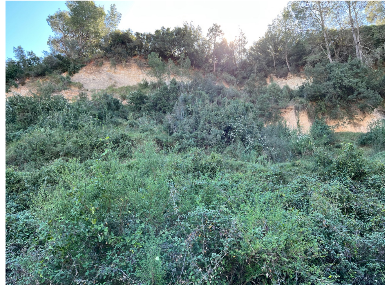
Ilustración 21. Talud colindante repleto de vegetación. Fuente: Elaboración propia.
