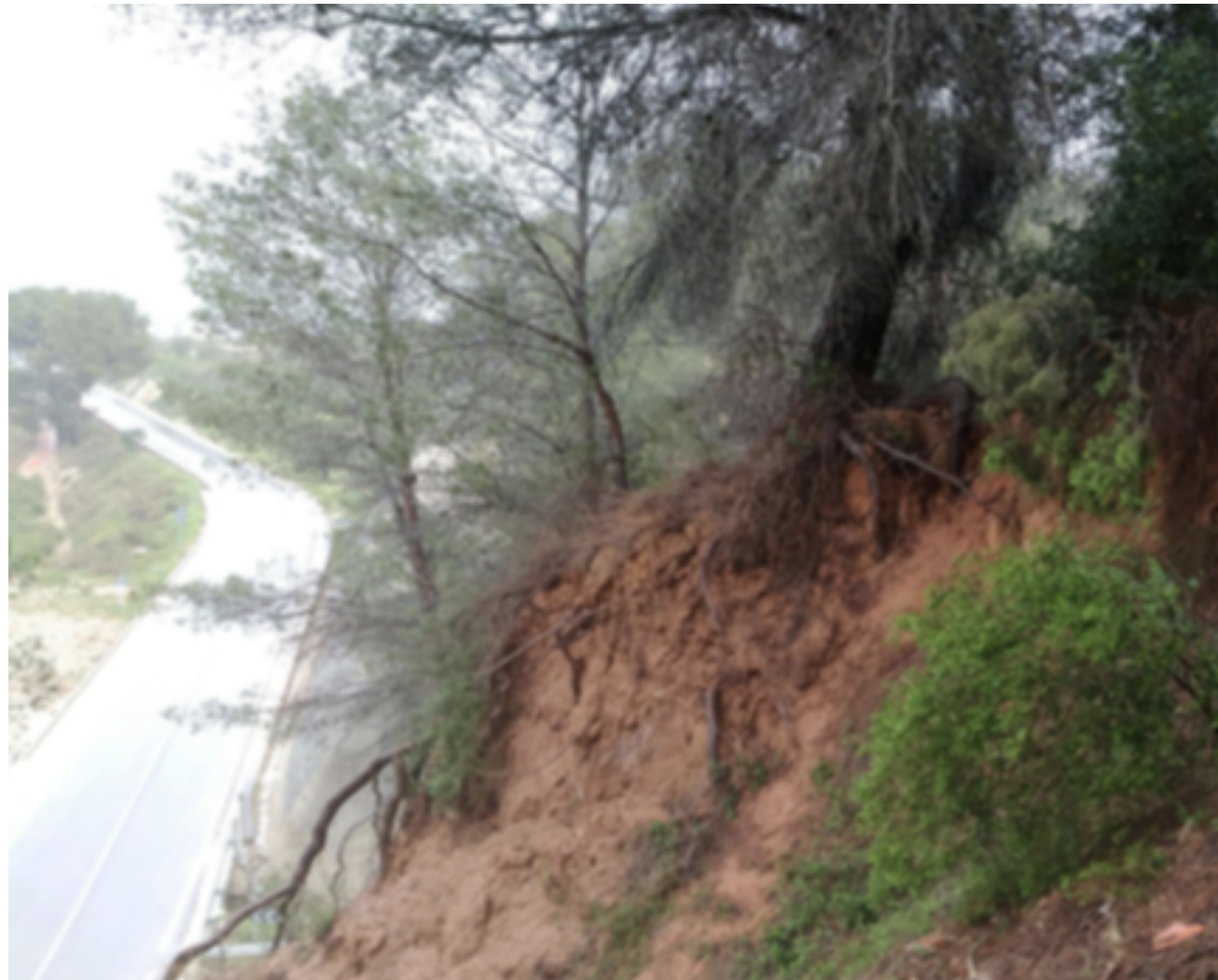
Ilustración 53. Arrastre y deslizamiento de la tierra vegetal. Fuente: Memoria Valorada "Acondicionamiento del talud del P.K. 1+980 de la CV-652. T.M. Moixent (Valencia).
