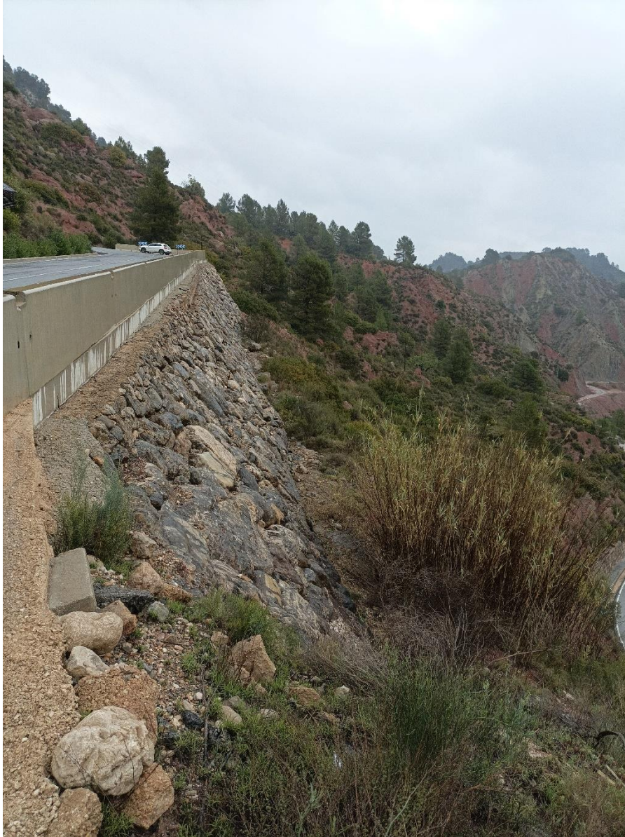
Figura 7: Losa de cimentación sobre muro de escolera. Fuente: Propia.
