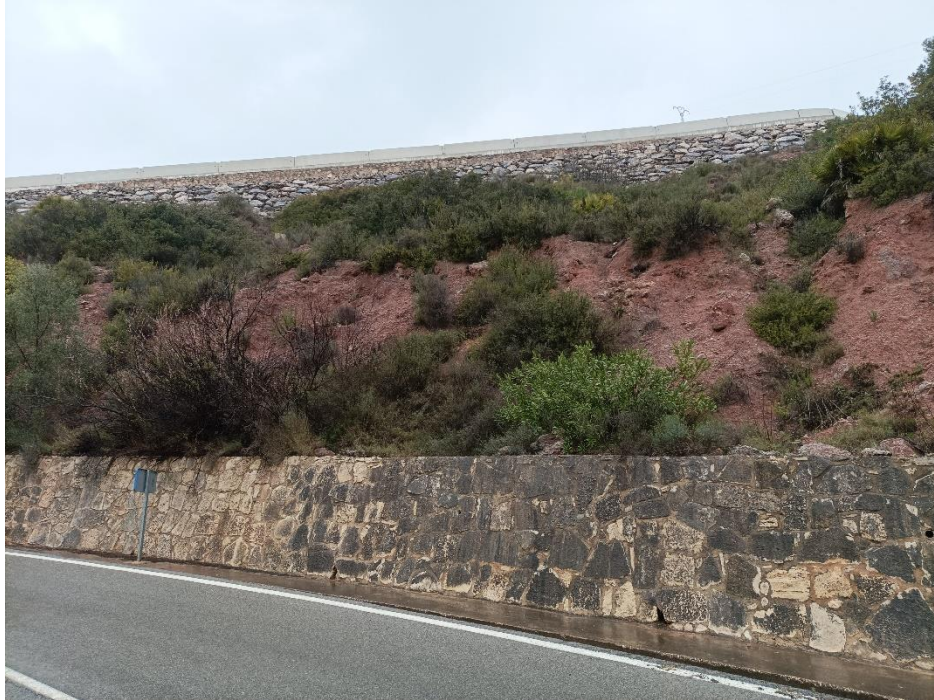
Figura 26: Muro de mampostería. Fuente: Propia.
