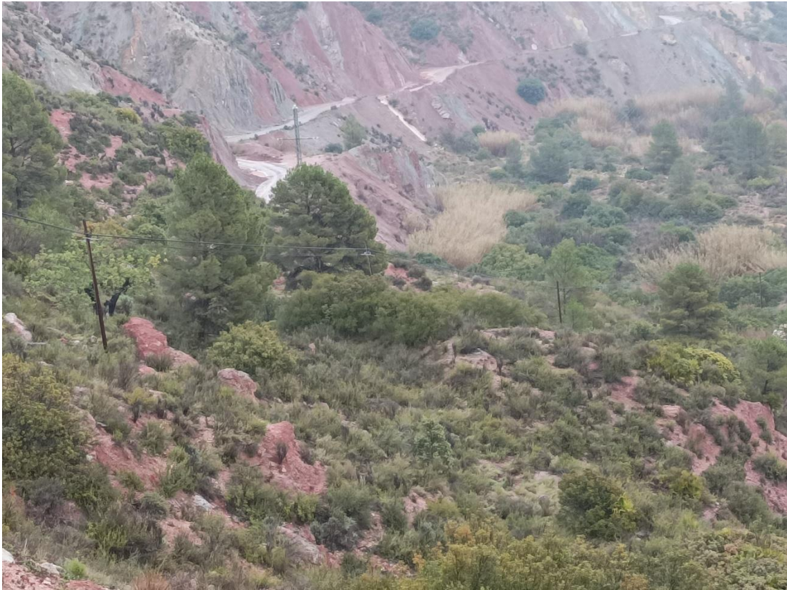
Figura 35: Infraestructuras de distribución de energía eléctrica. Fuente: Propia.
