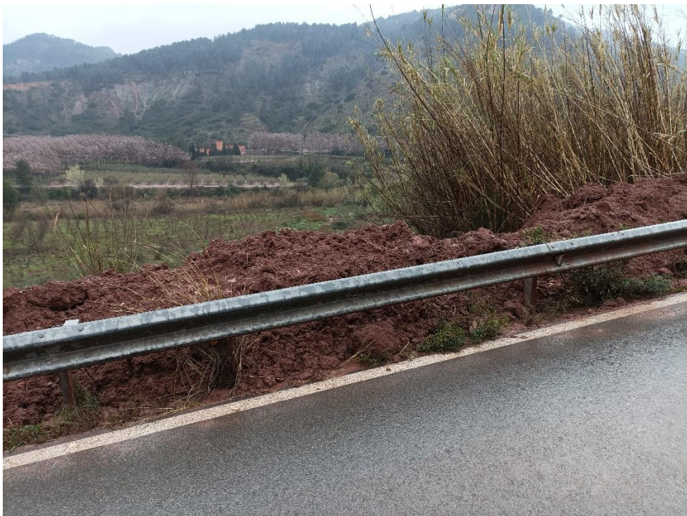
Figura 24: Movimiento de tierras. Fuente: Propia.
