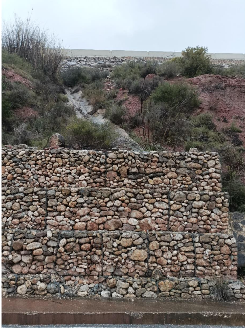
Figura 25: Muro de gaviones. Fuente: Propia.
