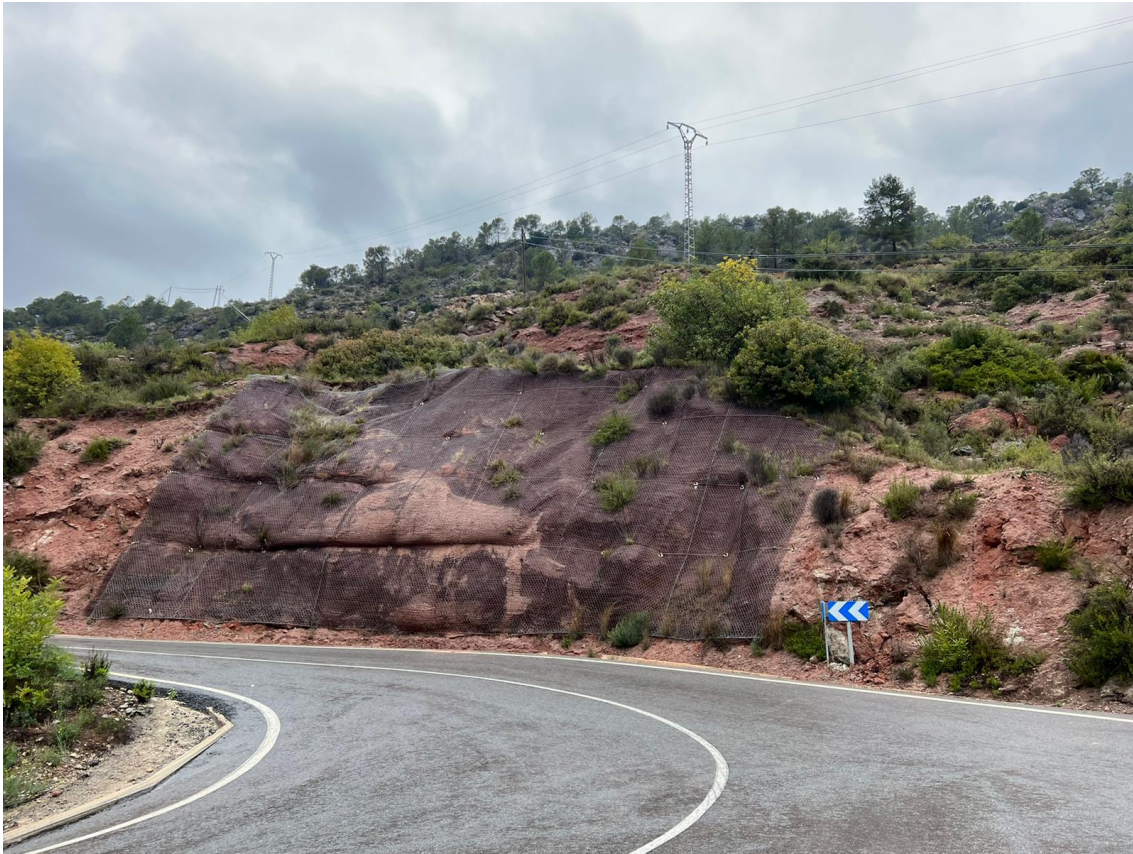
Figura 5: Malla de triple torsión anclada con bulones. Fuente: Propia.
