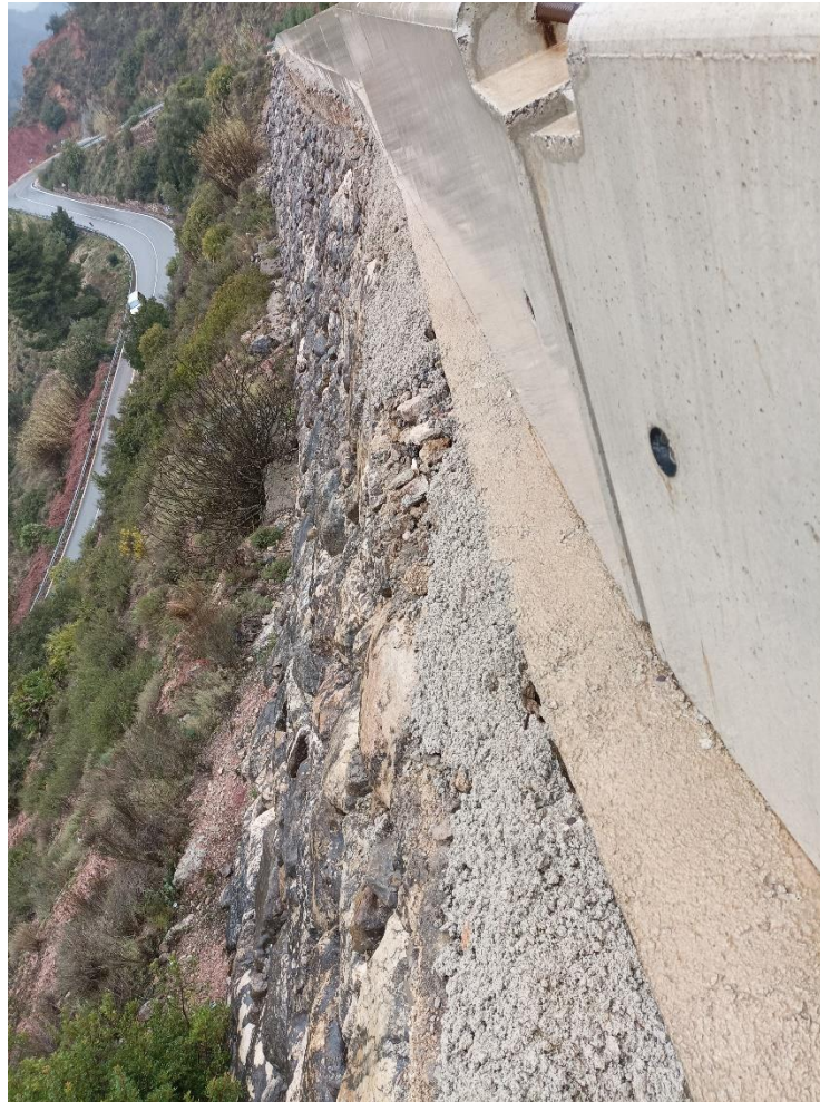
Figura 28: muro de escollera y losa de cimentación. Fuente: Propia.
