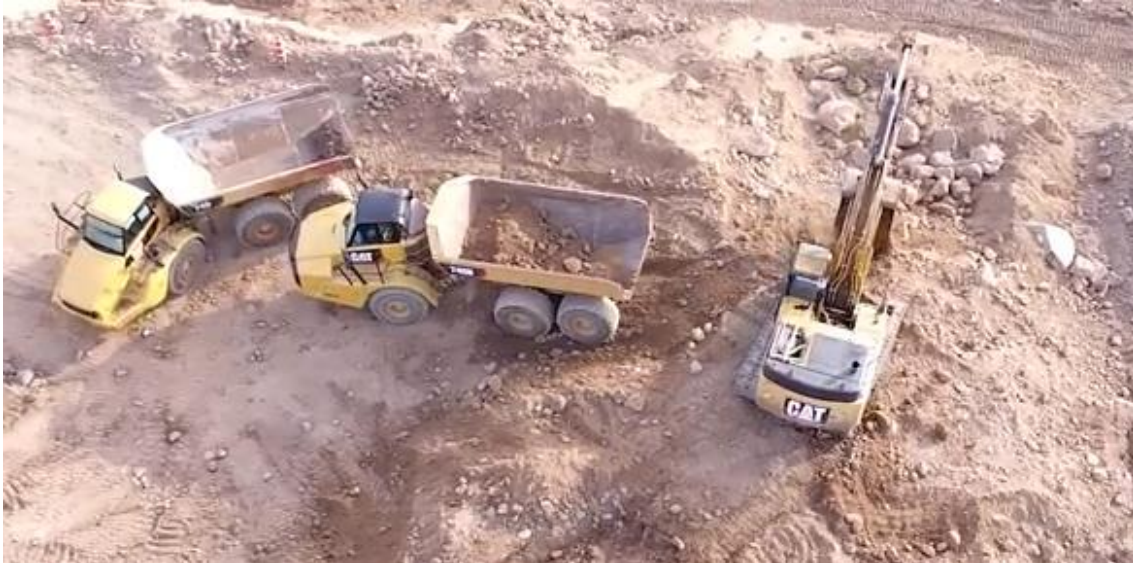
Figura 69: Maquinaria de excavación y transporte de suelos. Fuente: Constructora Makro Medios.
