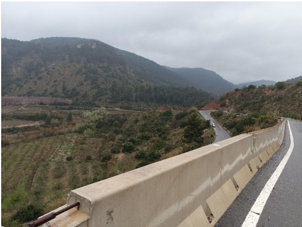
Figura 3: Barreras New Jersey margen derecho de la carretera. Fuente: propia.
