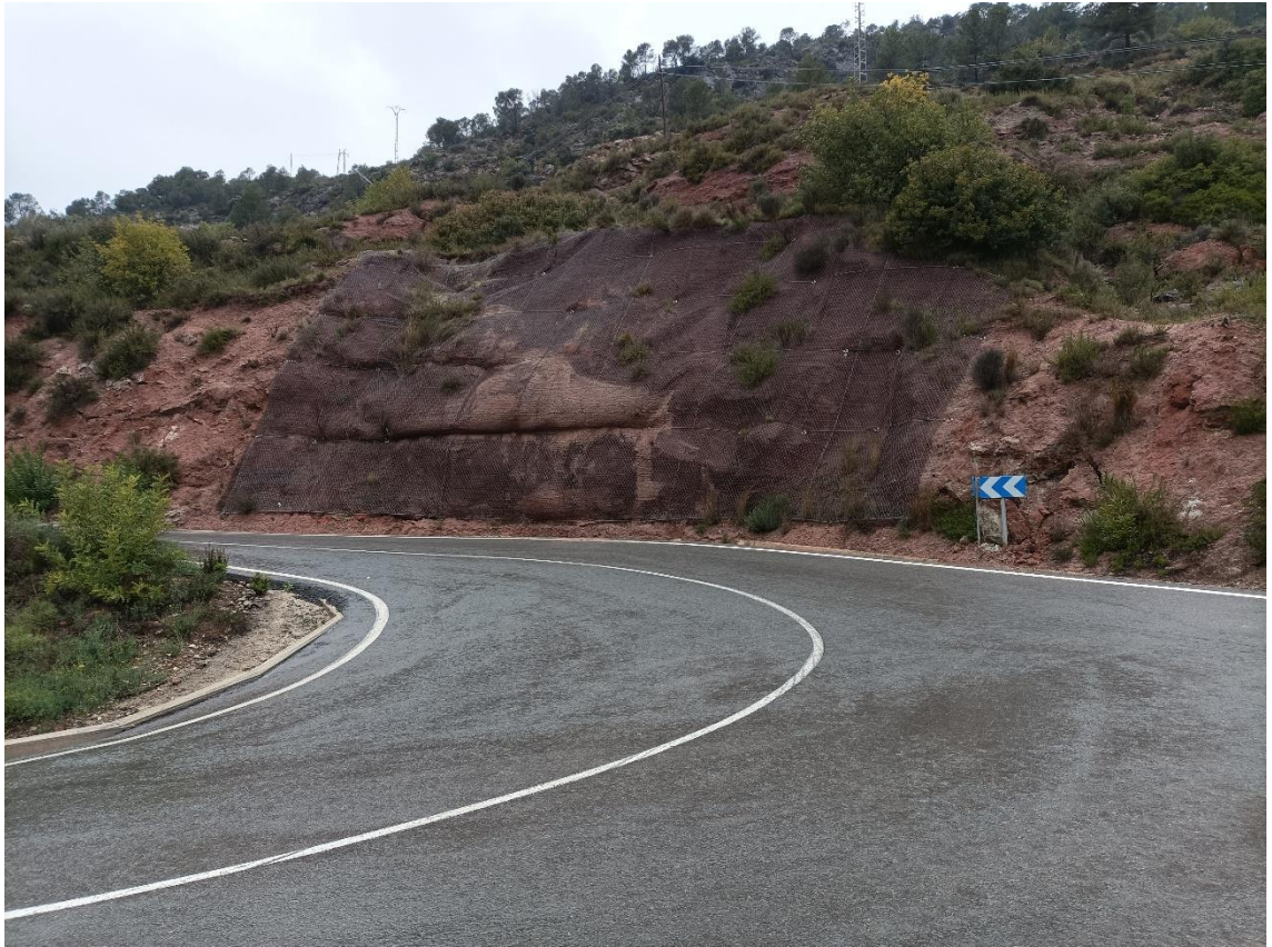
Figura 29: Fijado de malla al terreno con bulones. Fuente: Propia.
