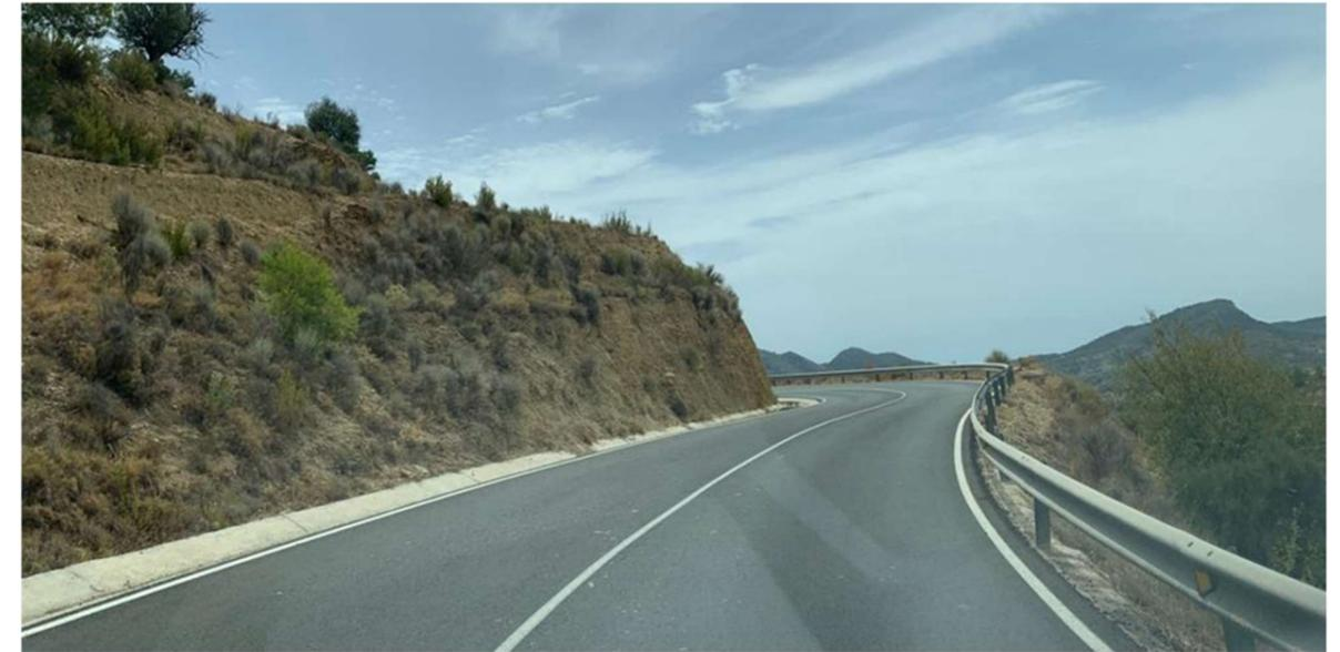
Figura 7. Curva a izquierdas con talud interior semiverical.
