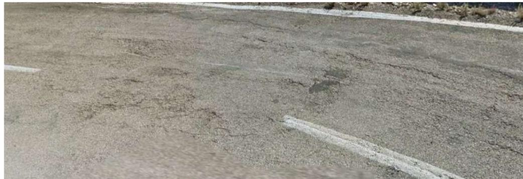
Figura 11. Deterioro del firme. (Fuente: Elaboración propia).
