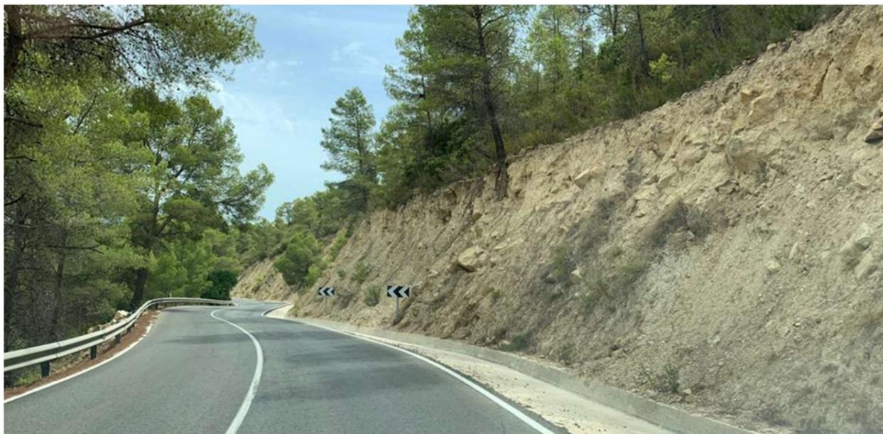
Figura 10. Desmorte con talud superior a 7 metros en el P.K. 28+263,34.
