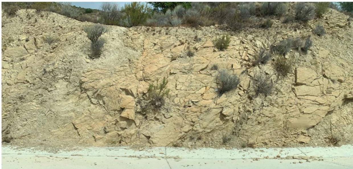
Figura 6. Calizas margosas del Terciario en el P.K. 25+100.
