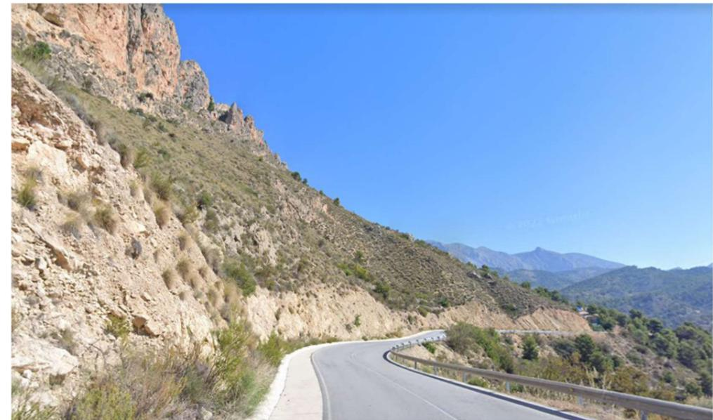
*Figura 2. Zona con riesgo de desprendimientos sobre el P.K. 4+430. (Fuente: Elaboración propia).*
