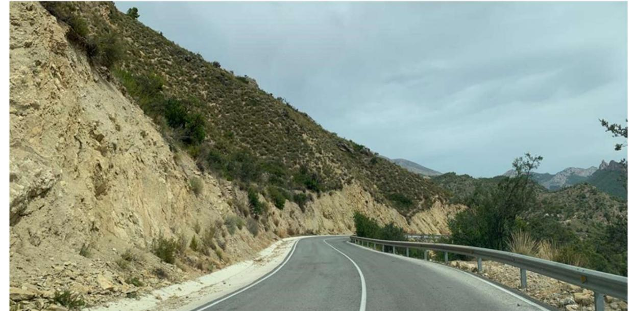
Figura 12. Desmontes en el tramo final a media ladera con taludes superiores a 10 metros.
