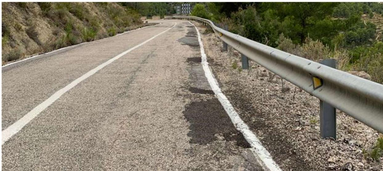
Figura 14. Deterioro del firme conocido como "firme brillante".
