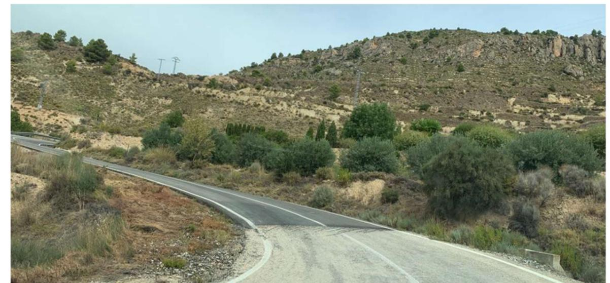
Figura 16. Falta de unificación del firme.
