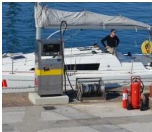
Figura 8: Extintores cerca del surtidor. Fuente: https://www.escuelamaritima.es/blog/%C2%A1accidentes-no-recomendaciones-para-repostar-la-embarcaci%C3%B3n
